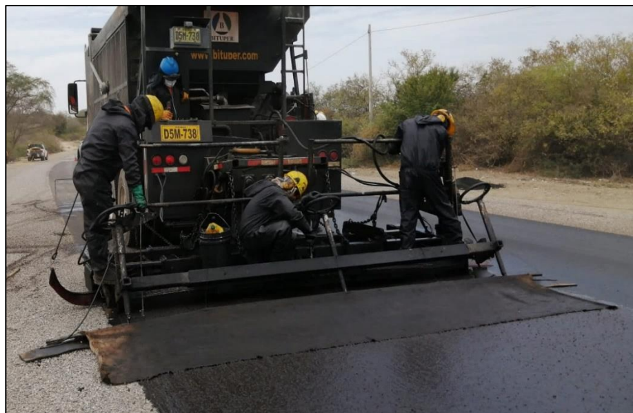
Figura 39. Aplicación de micropavimento
