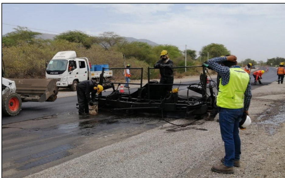
Figura 38. Limpieza de caja esparcidora
