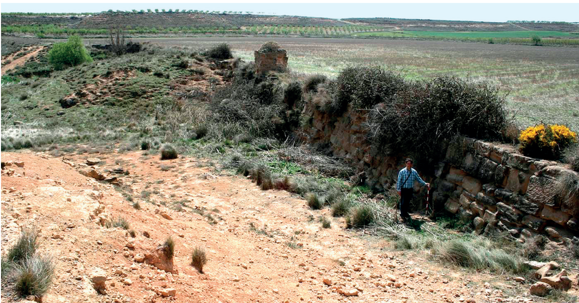
Figura 7 Presa de La Estanca
