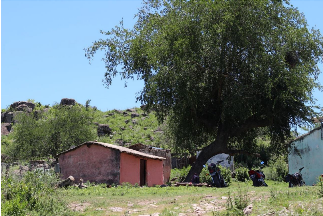
Fig. 3. Vivienda campesina de adobe en zona de Tulumba, Córdoba, Argentina. Fuente: autoría propia (2019).
