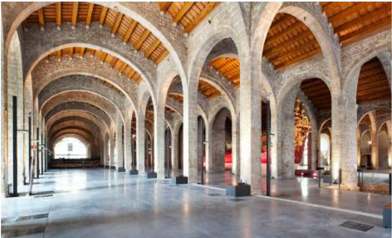
Foto del interior de las Reales Atarazanas con las naves cubiertas con arcos de diafragma. (Foto: J. Biel. Museu Marítim de Barcelona).
