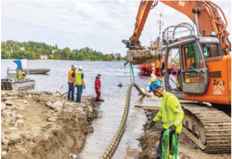
Vesikaapelin rakentaminen yhteistyössä eri toimijoiden kanssa elokuussa 2021. Kuva: Suur-Savon Sähkö -konserni.
