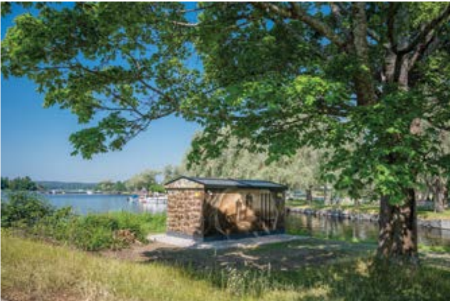
Pyrkimyksenä samantaajuinen jännite – muuntaja Savonlinnassa. Kuva: Suur-Savon Sähkö-konserni.
