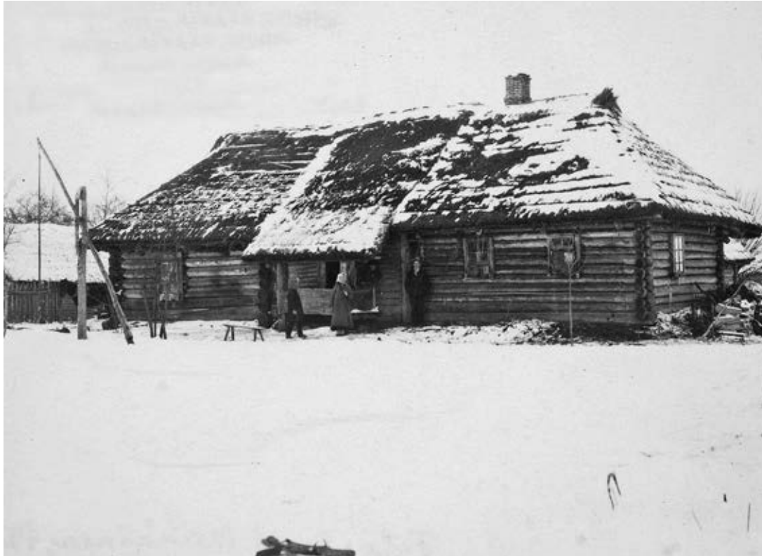
Petra Palan talon pihanpuoleinen julkisivu Jaastrovan kylässä, edessä vasemmalla vinttikaivo. ERM.
