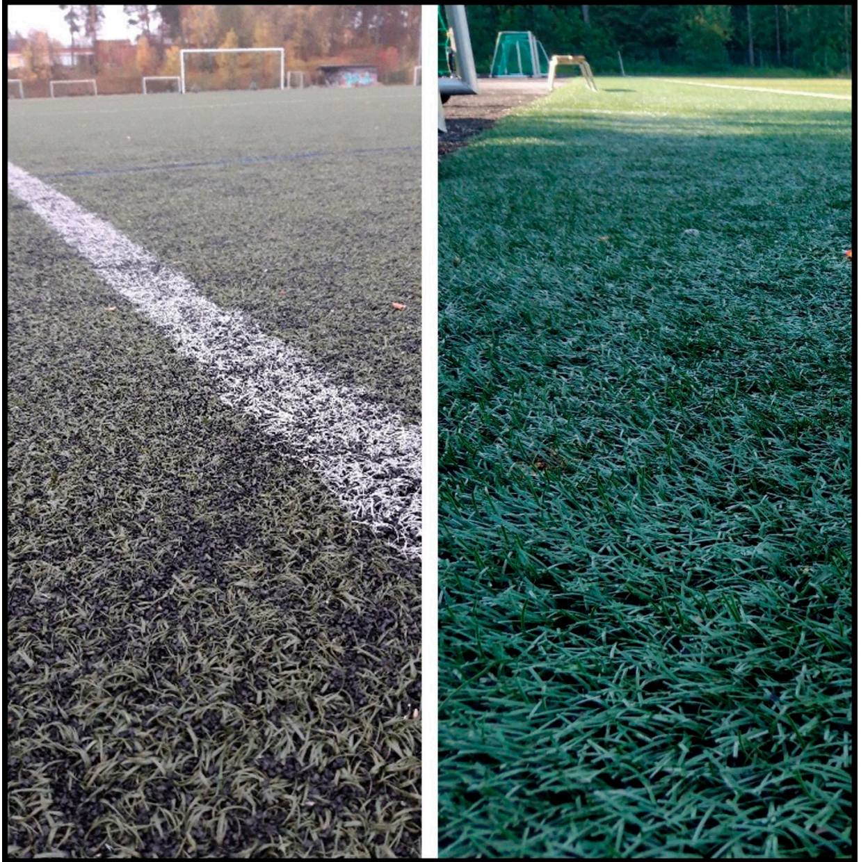
Kuva 25. Puotilan kentällä (vasen) pystyasennossa olevan nukkalangan välissä näkyi selvästi enemmän kumirouhetta kuin Pirkkolan kentällä (oikea), missä nukkalanka peitti alleen kumirouheen. Kuvat: Maiju Lehtiniemi & Jyri Tirroniemi.
