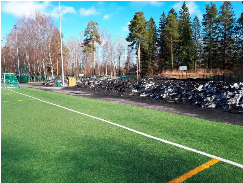
Kuva 6. Pirkkolan kentän lumenläjitysalue sijaitse osittain tutkimuskaivojen 3-4 valuma-alueella
