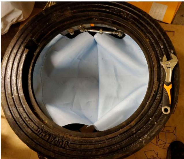
Kuva 3. Hulevesisuodatin, eli näytekeräin kaivon asennettuna. Kuva: Wateco Oy
