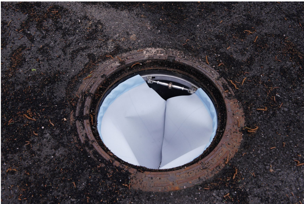
Kuva 9. Paikalleen asennettu hulevesisuodatin. Kuva: Jyri Tirroniemi.
