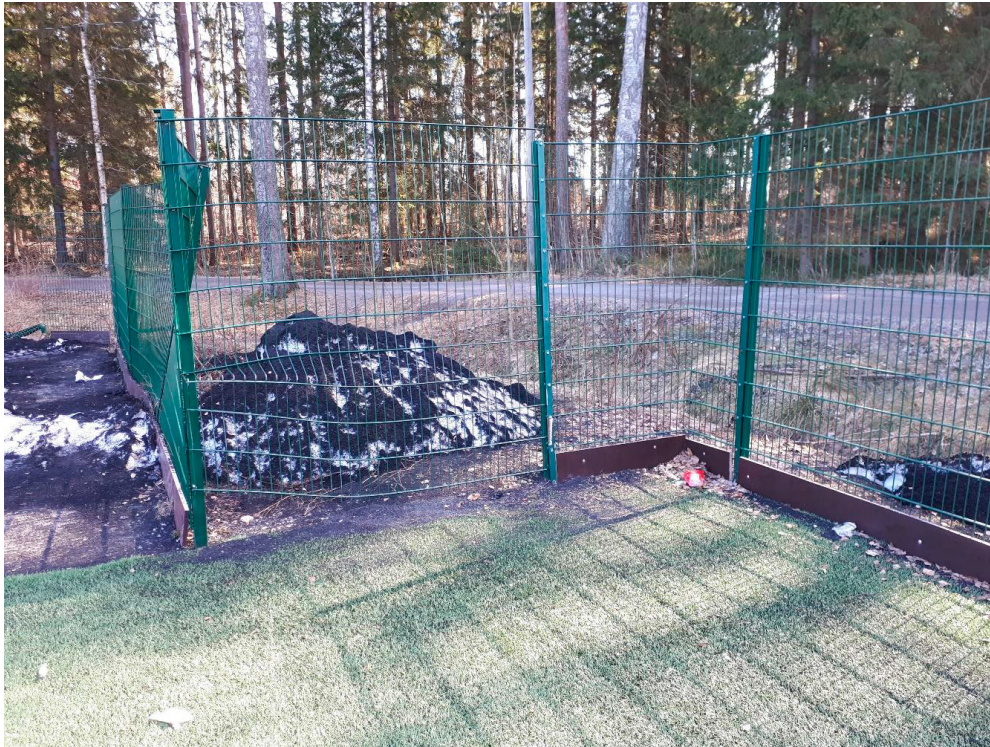
Kuva 1. Aitaan asennettujen estelevyjen ja lumenlajitusalueen oikealla mitoituksella sekä asennus-/huoltotyön laatuvaatimuksilla voisi ehkäistä kuvassa näkyviä tilanteita, joissa rouhe leviää esteiden yli ympäristöön.
