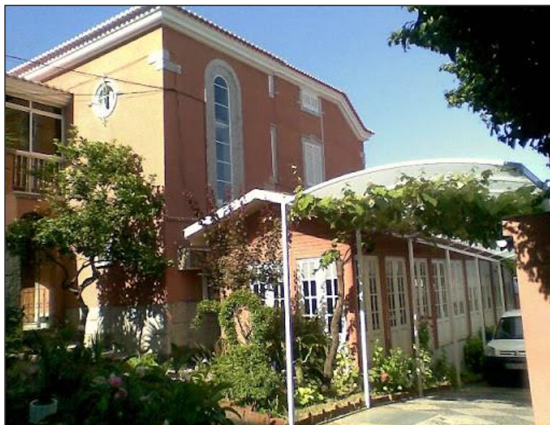
Figura 20- Vista de um dos edifícios à entrada do estabelecimento de ensino (Fonte: EPHTL, 2018).
