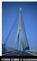
PONTE SOBRE O GUADIANA
