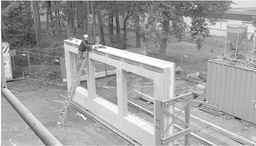
Abbildung 3.3: Anschlagen eines Sandwich-Fertigteils in der Transportbox (Foto: Jan Schumann, 2015-06-22)
