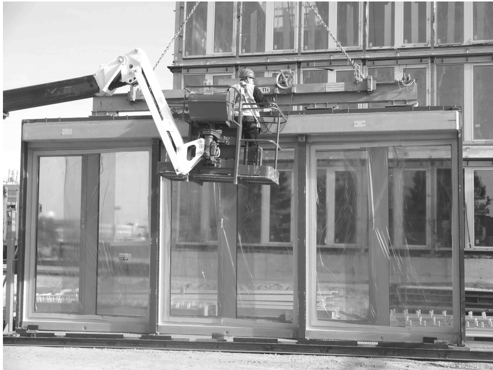
Abbildung 3.1: Anbringen der Traverse an ein Fertigteil-Fassadenelement (Foto: Daniel Schmitz, 2015-04-24)
