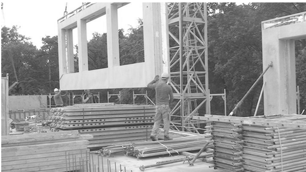
Abbildung 3.4: Einschwenken eines Sandwich-Fertigteils (Foto: Jan Schumann, 2015-06-22)
