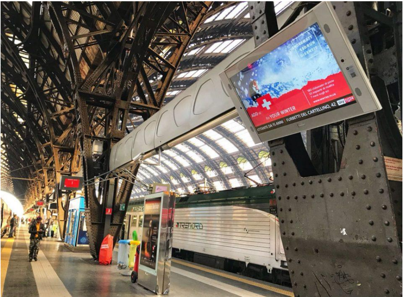
Figura 66: Impianto Grandi Stazioni Media (Stazione di Milano Centrale)
