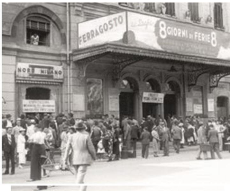
Figura 16: La facciata della stazione di Cadorna (Milano) ricoperta da manifesti pubblicitari nel 1930 (fonte: Ufficio stampa LeNord)
