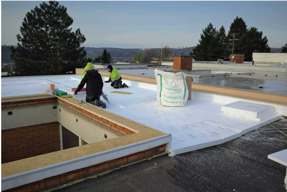
Obrázek (20) – Pokládka izolace [63]
