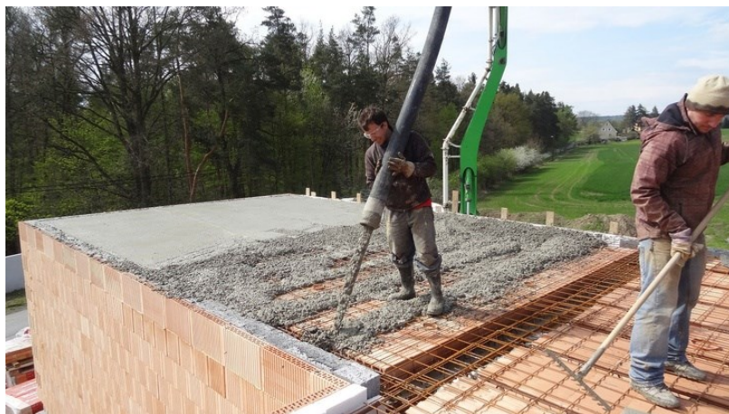
Obrázek 24 - Betonáž stropní konstrukce [36]
