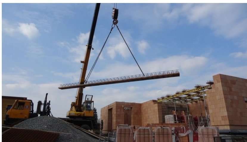
Obrázek 12 - Usazování stropních nosníků pomocí jeřábu [32]
