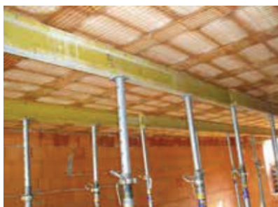
Obrázek 11 - Provizorní podchycení stropu [15]
