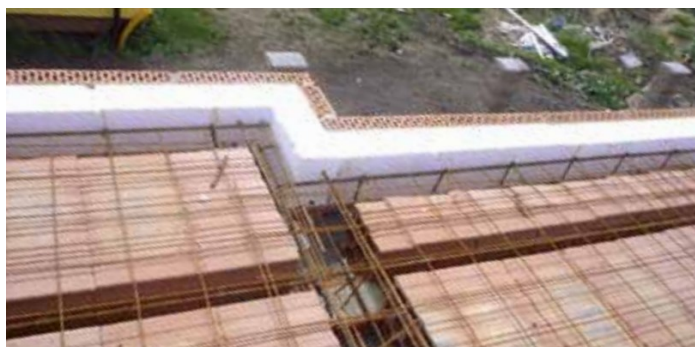
Obrázek 22 - Vyzděná věncovka s tepelnou izolací [34]
