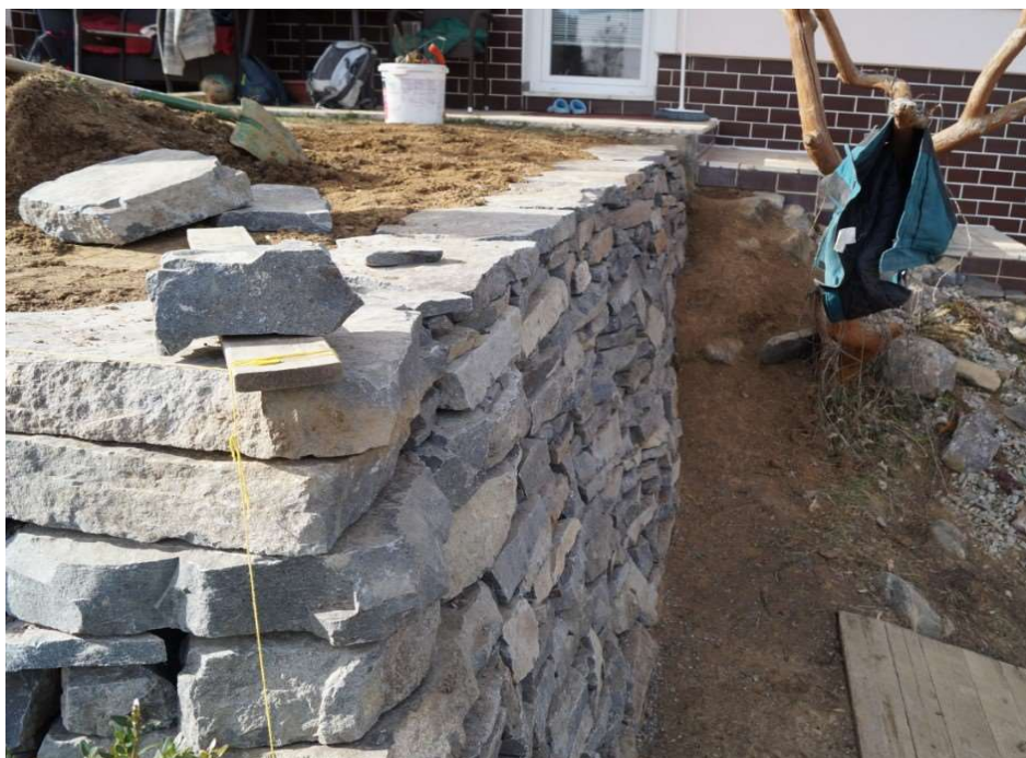
Obrázok 4: Gravitačný múr z kameňa ukladaného na sucho [22]
