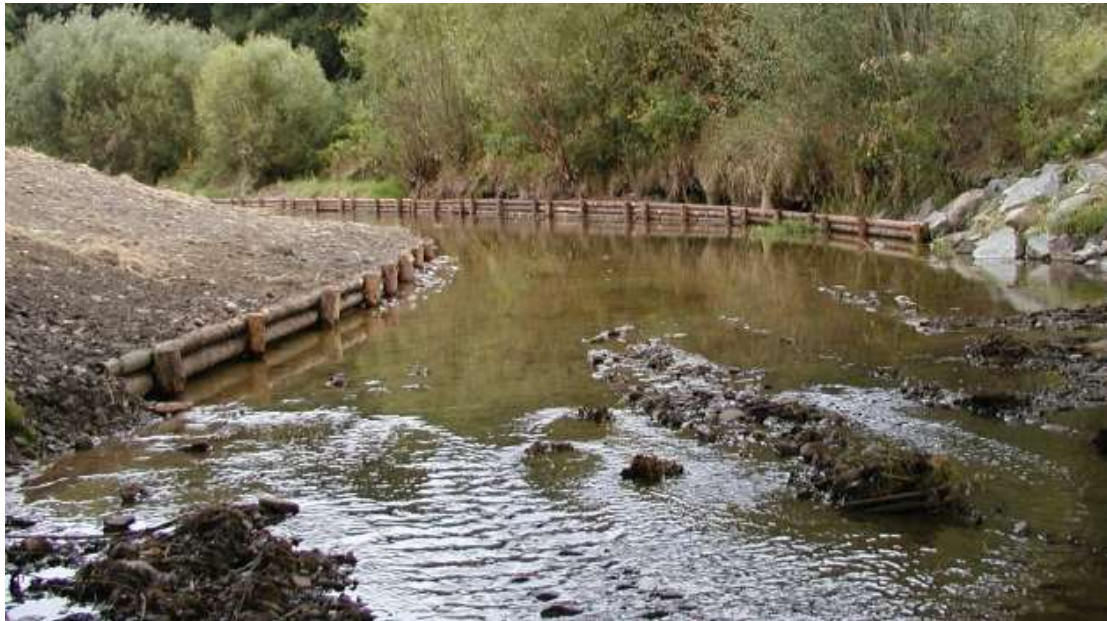
Obrázok 32: Stabilizácia brehu guľatinou [15]
