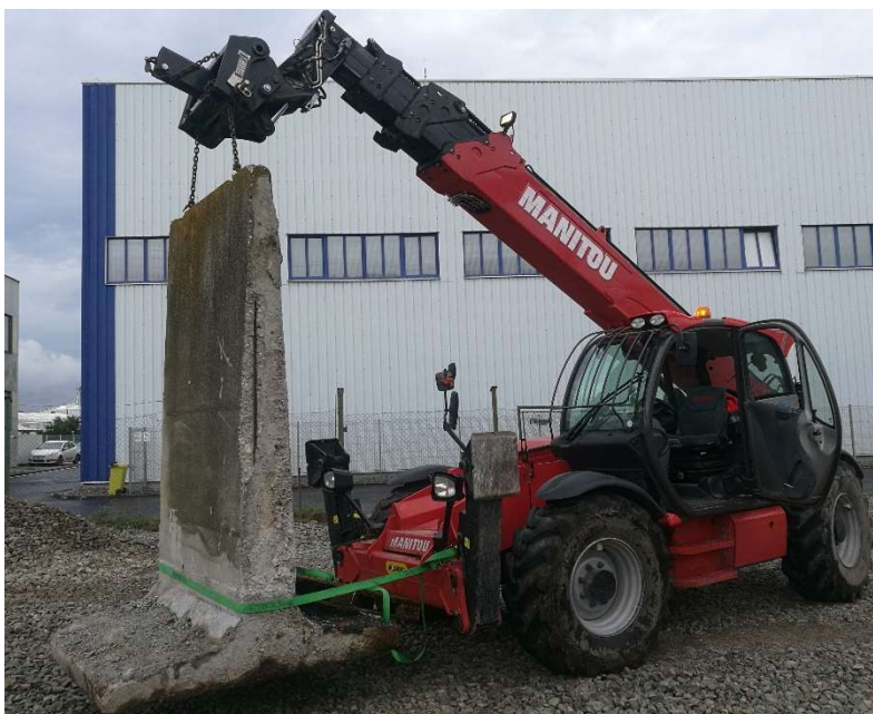
Obrázok 14: Transport prefabrikovaného múru – fotka autor
