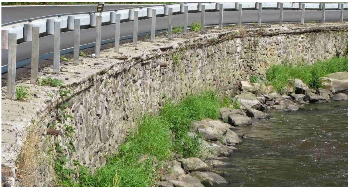
Obrázok 6: Gravitačný múr z kameňa ukladaného na maltu [29]
