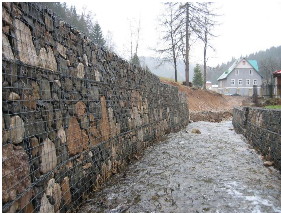
Obrázok 18: Gabionový múr pozdĺž vodného toku [25]
