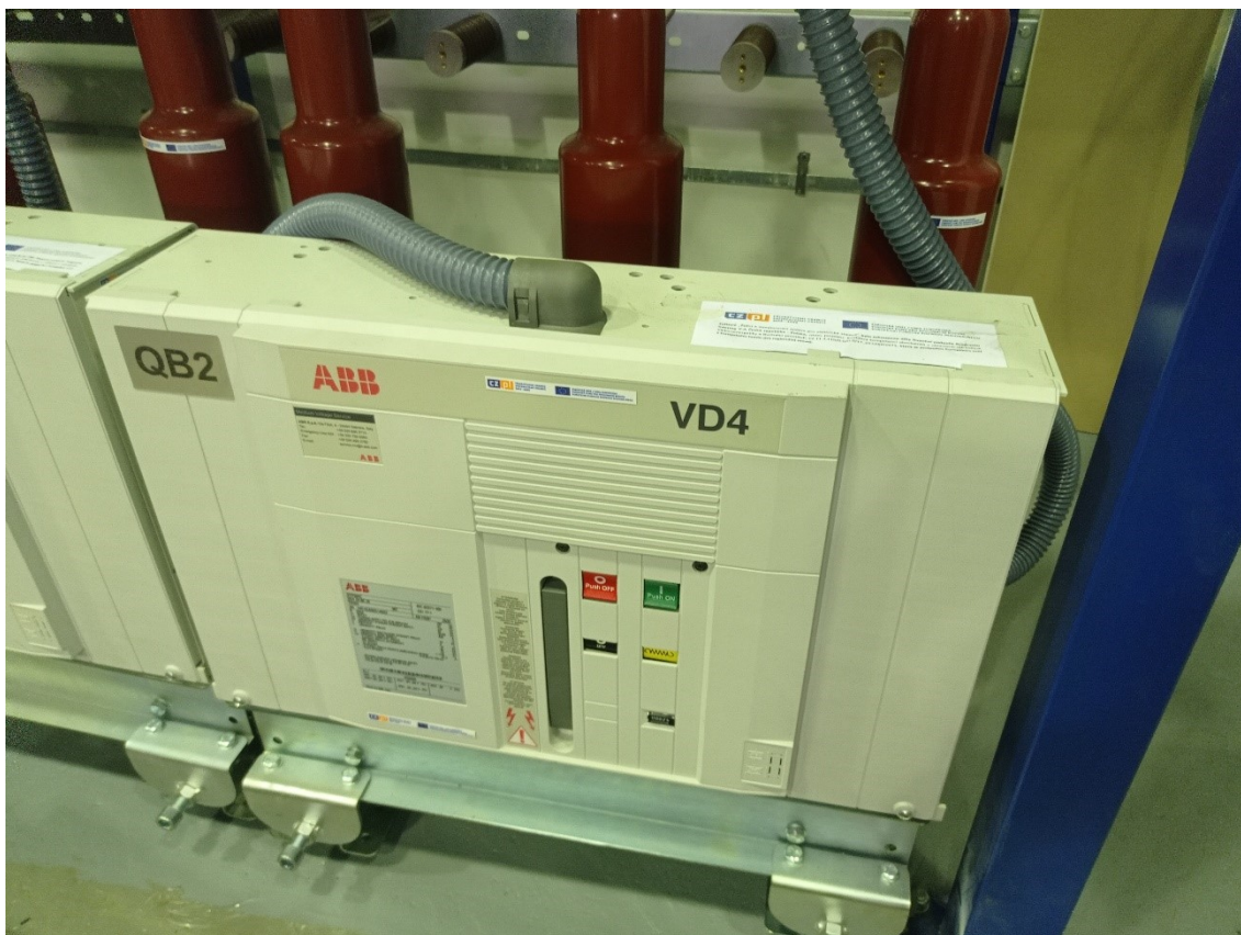
Obr. 1 (Vakuový vypínač VD4 na rozvodně HARD)
