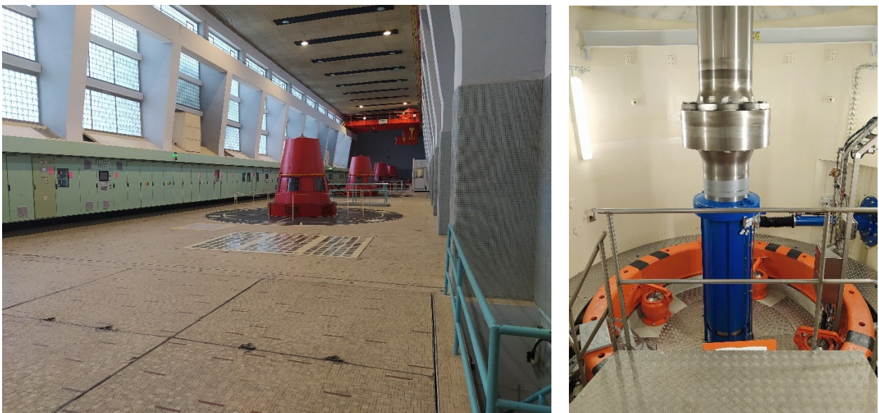
Obrázky 9.3 a 9.4 – Strojovna a hřídel turbíny
