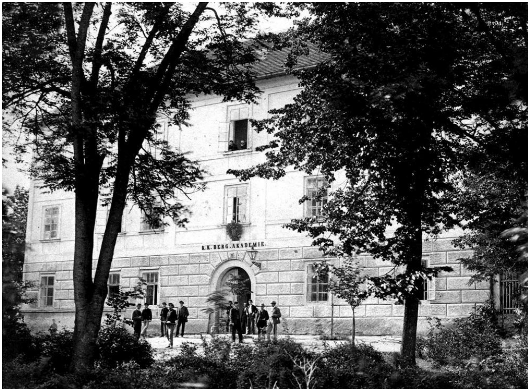
Obr. 3.1. Budova VŠB - TUO v Příbrami
