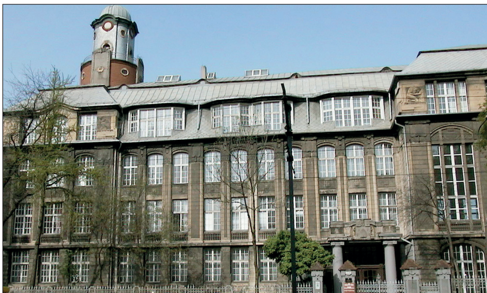
Fot. 14. Gmach Wydziału Filologicznego w budynku dawnego Gimnazjum Niemieckiego przy al. Kościuszki 65. Ze zbiorów Archiwum UŁ
