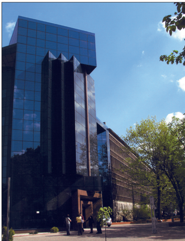
Fot. 50. Fragment części starej i nowej Biblioteki Uniwersytetu Łódzkiego przy ul. Jana Matejki 32/38 (2008 r.) Ze zbiorów Archiwum UŁ
