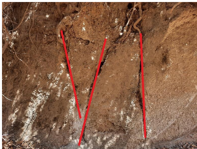
Foto 20. Sistemas de fracturas paralelas con orientación NW-SE, con coordenadas UTM 540319 E, 1367000 N.
