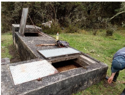
Ilustración 2 Desarenador planta Olarte
