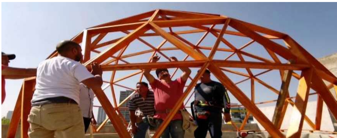
Figura 4. Construcción de un Glamping.
