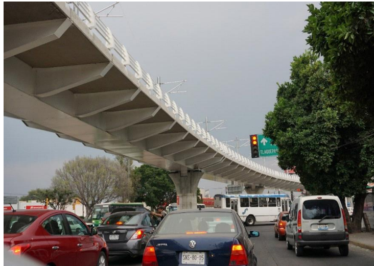
Foto G4 L3TEU Avances de obras L3TEU, municipio de Tlaquepaque (diciembre 2017)
