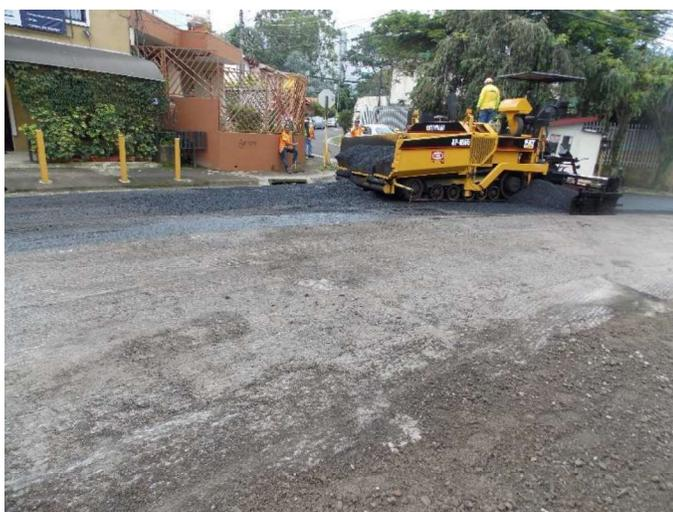
Figura 22. Proceso de colocación de sobrecapa en la Ruta Nacional de travesía 11505, agosto de 2018.
