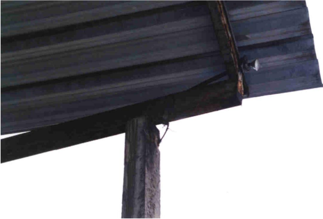
Fotografía-15 "Unión" viga-columna de estructura de concreto
