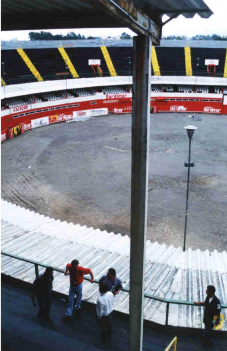
Fotografía-14 Vista general de esquinas del techo
