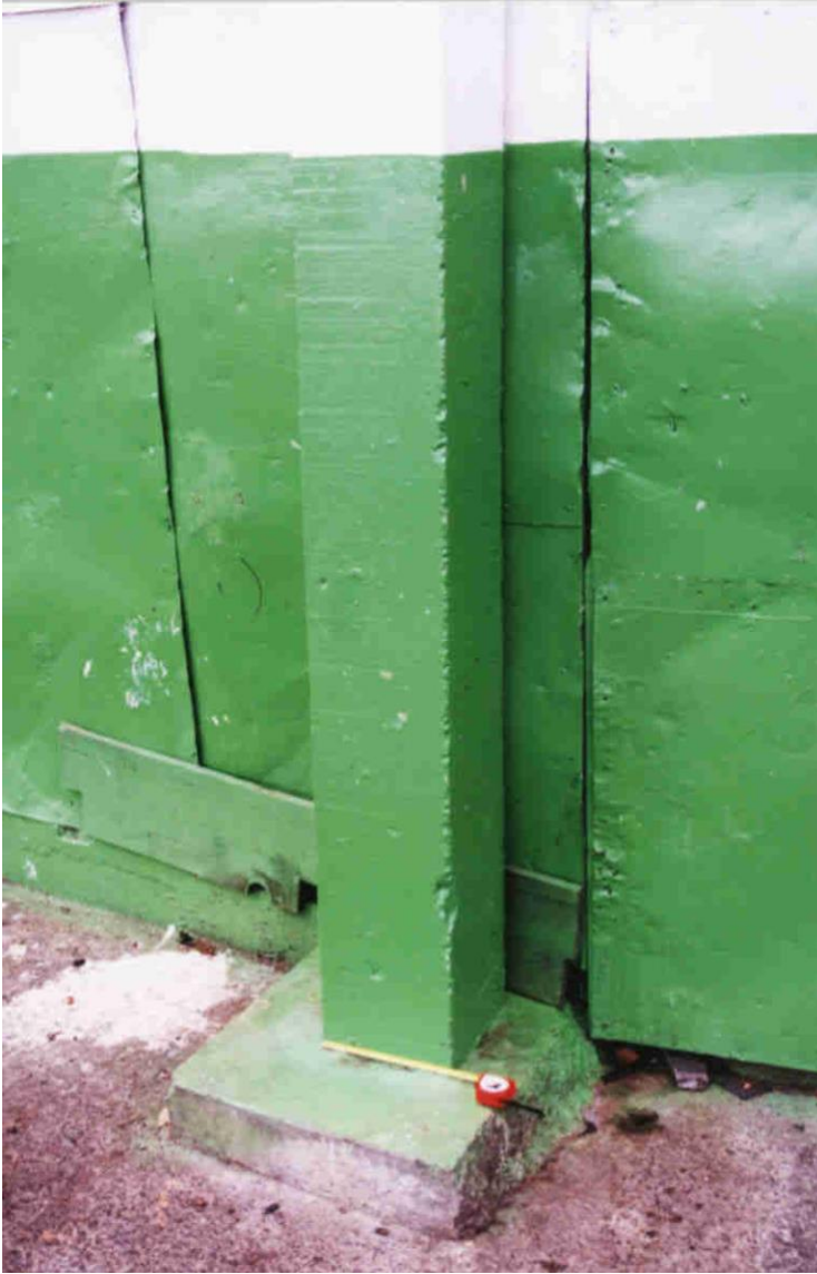
Fotografía-9 Conexión de columna a fundación
