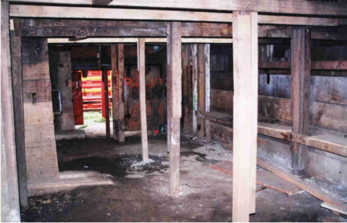
Fotografía-12 Apoyos de columnas
