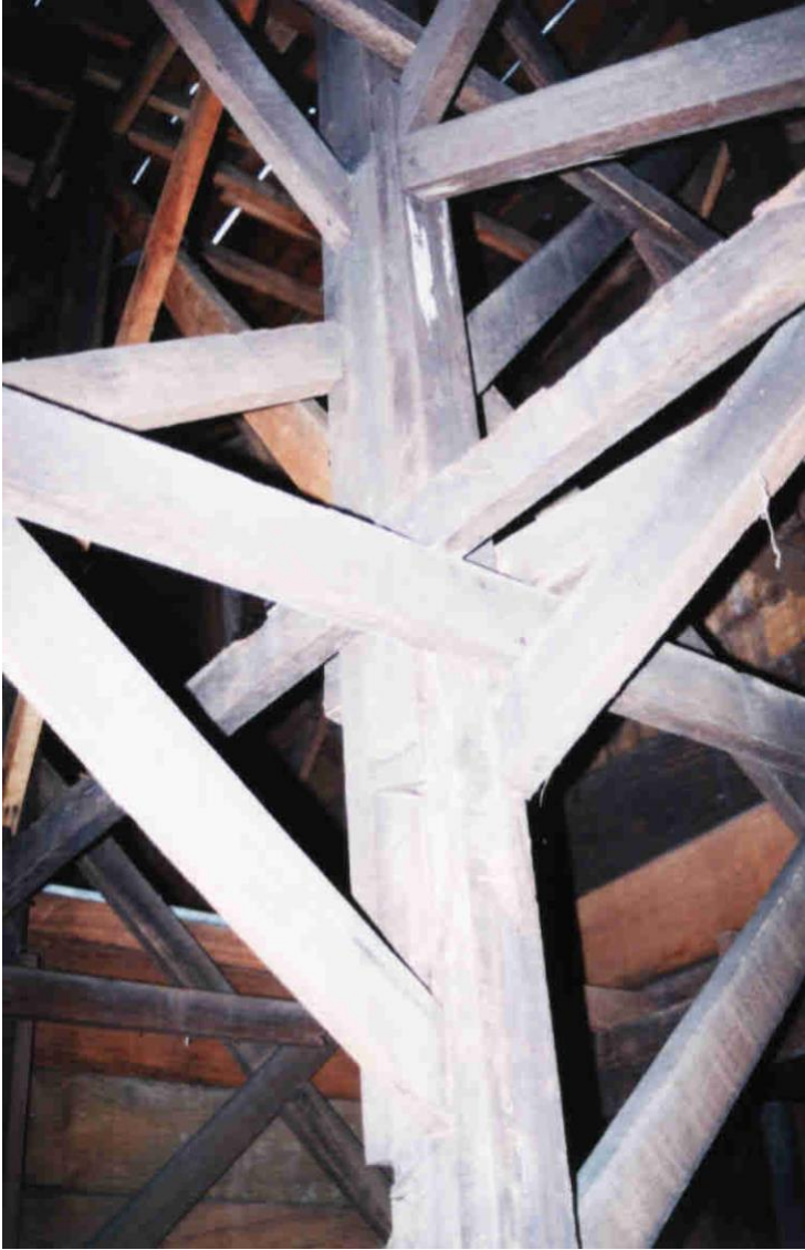
Fotografía-13 Arriostres diagonales y horizontales en una columna de madera
