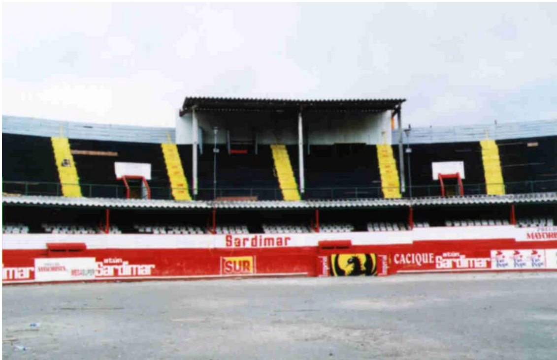
Fotografía-8 Zona techada del Redondel
