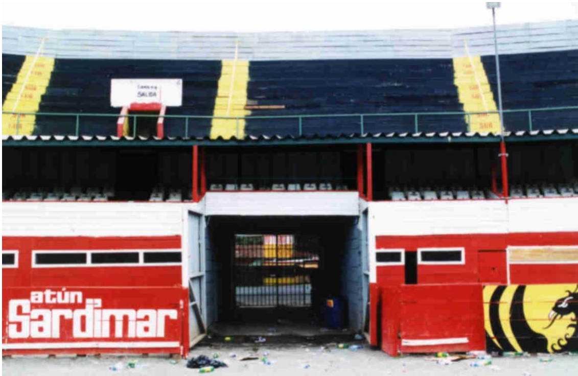
Fotografía-7 Rampa de acceso al Redondel
