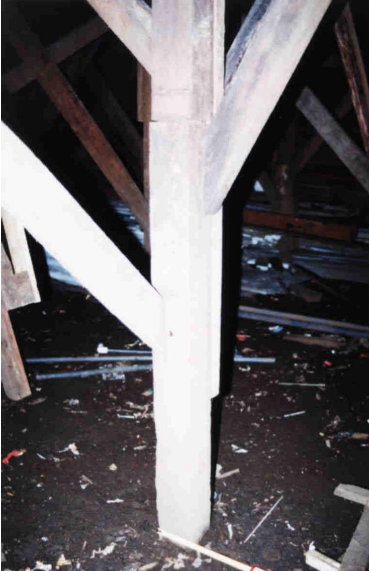
Fotografía-11 Apoyo de columna
