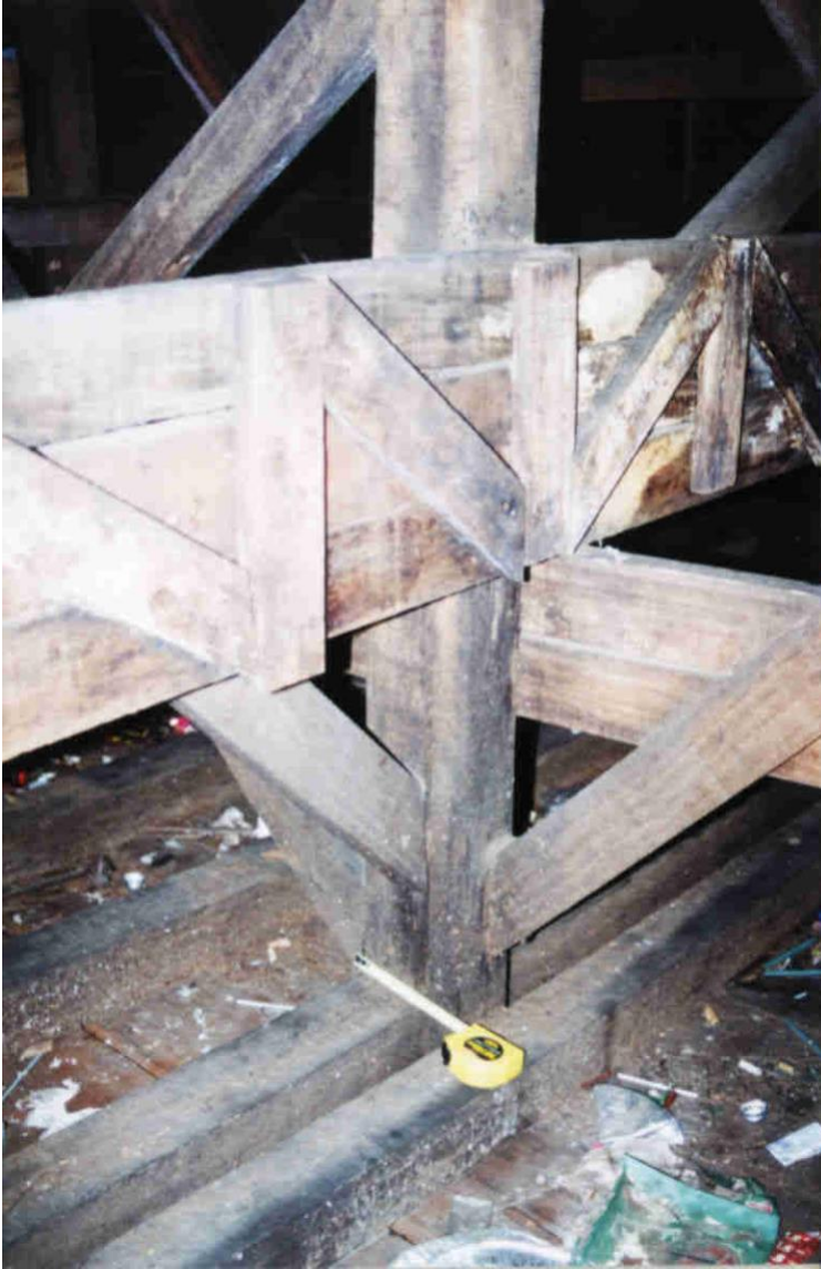
Fotografía-16 Estructura de soporte de la gradería en sector "rampa" de acceso
