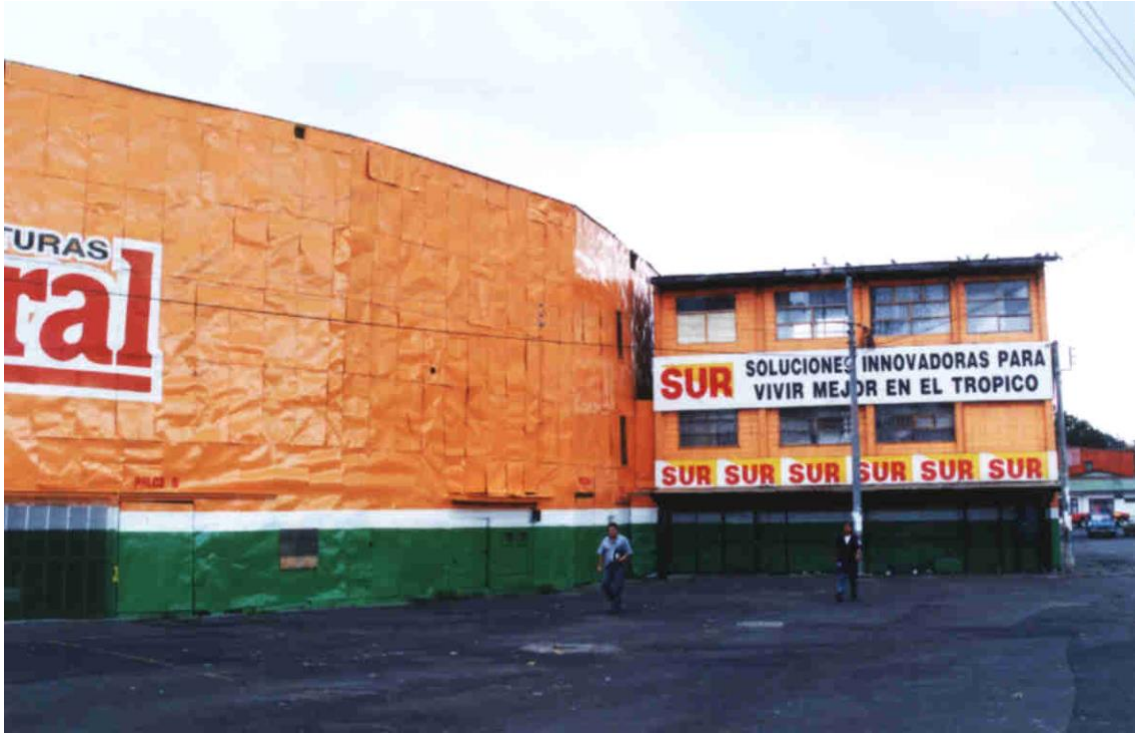
Fotografía-5 Pared externa #1 de la estructura
