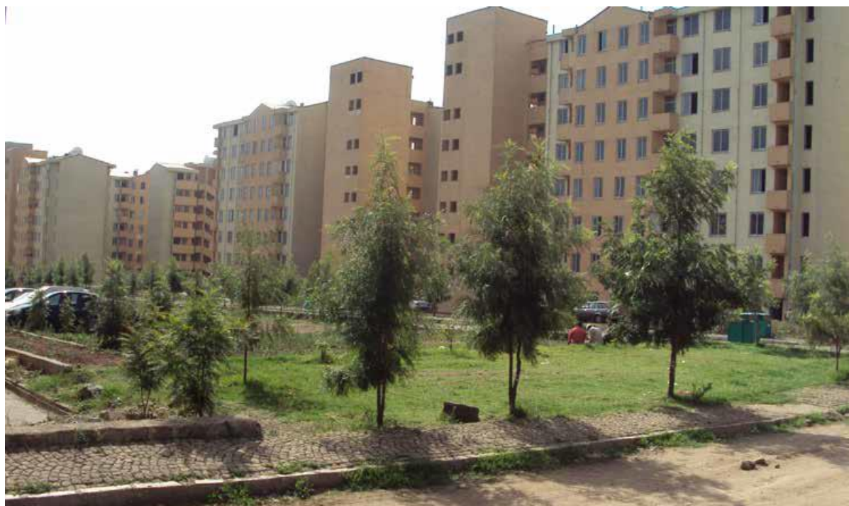
Figura 5: Resultados del reajuste de tierras y construcción del proyecto
