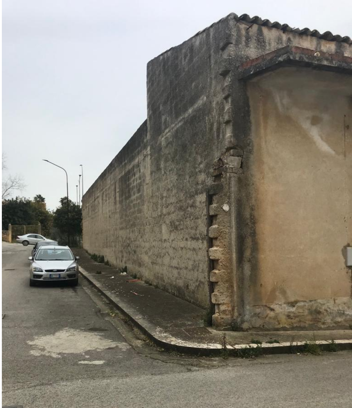
Figura 5.18. Vista laterale dell'edificio – ante intervento
