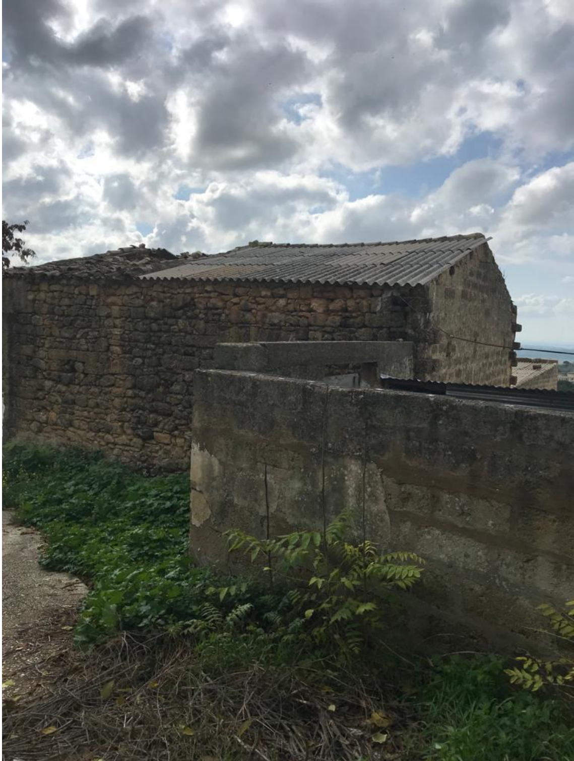
Figura 5.30. Vista posteriore d'insieme dell'edificio – ante intervento
