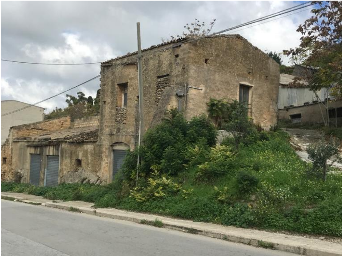
Figura 5.29. Vista anteriore d'insieme dell'edificio – ante intervento
