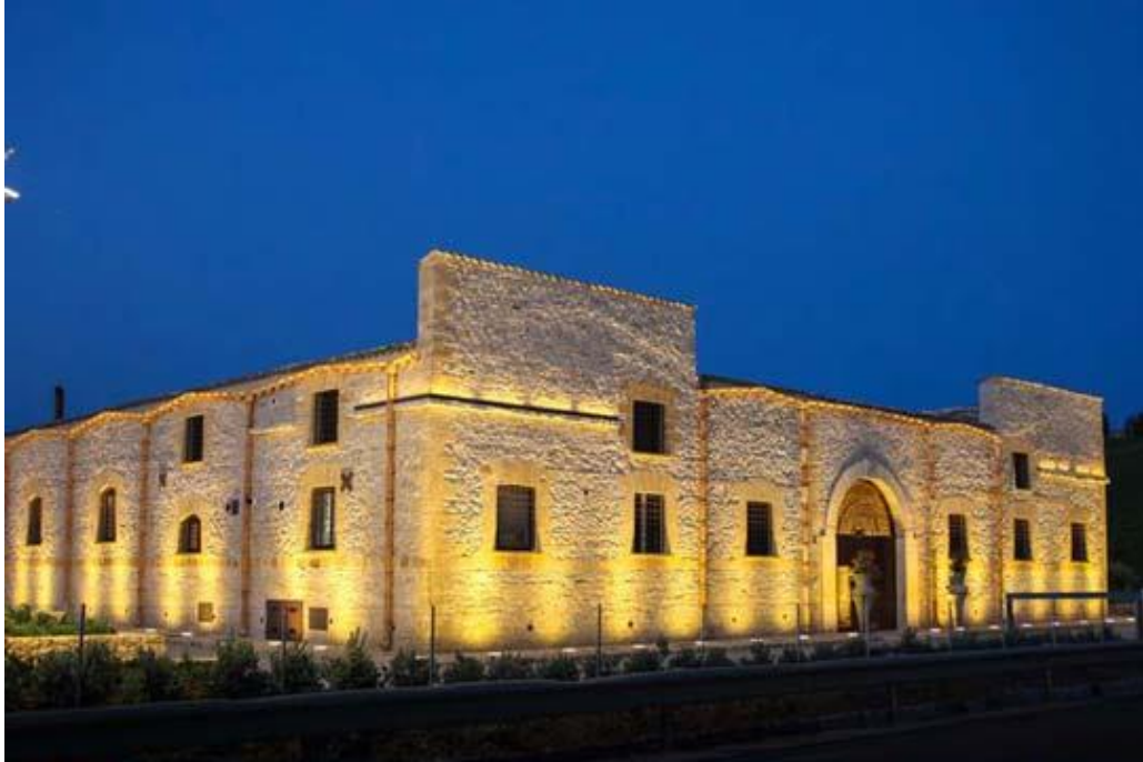
Figura 5.40. Vista ingreso principal de Baglio Passofondo
