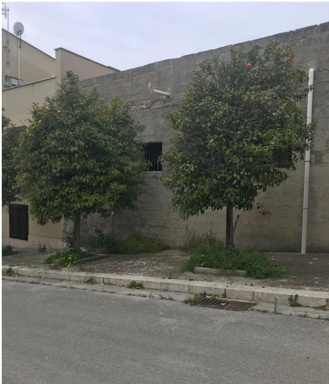
Figura 5.17. Vista del retro dell'edificio – ante intervento
