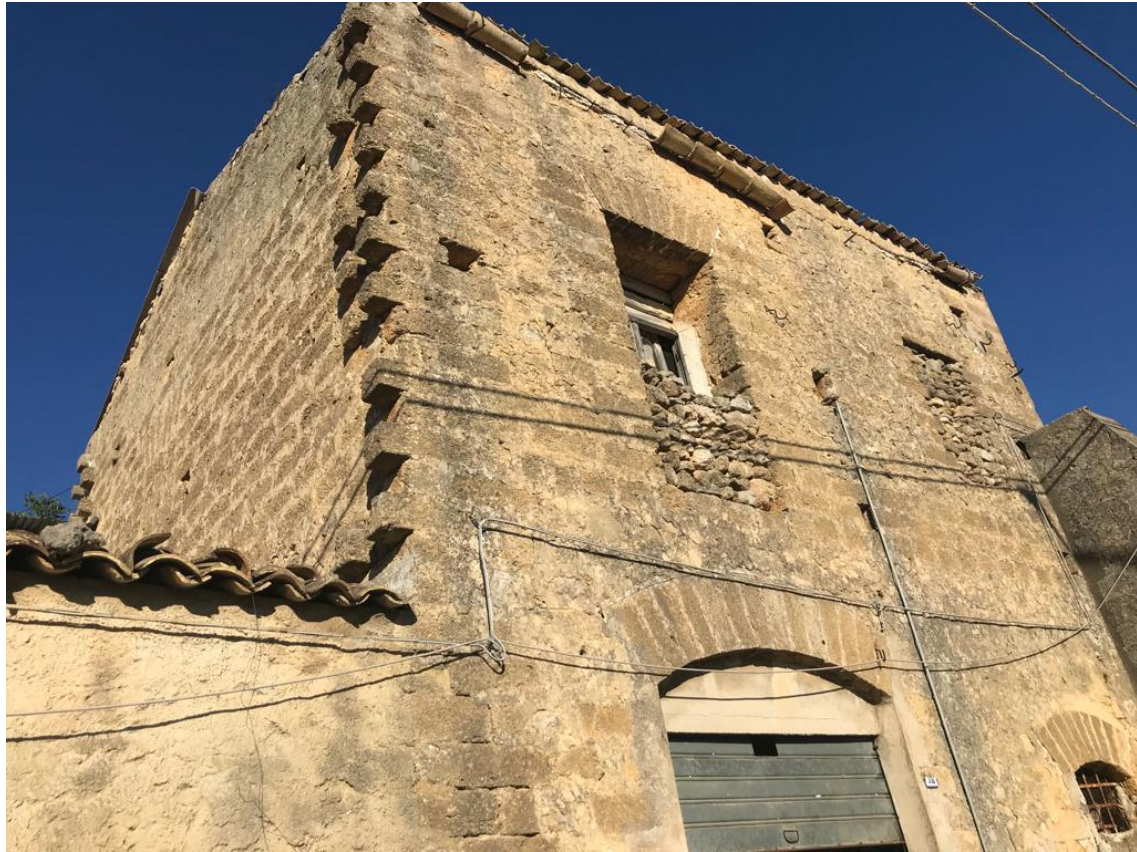
Figura 5.26. Vista anteriore dell'edificio - ante intervento
