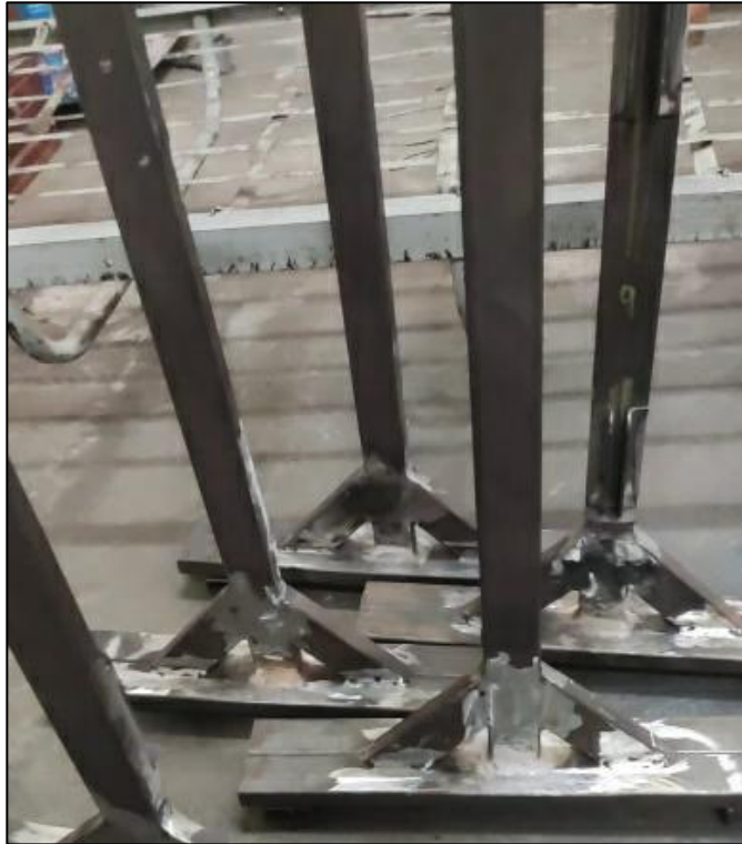
Figura 3.7 Estructura del tablero del alternador
