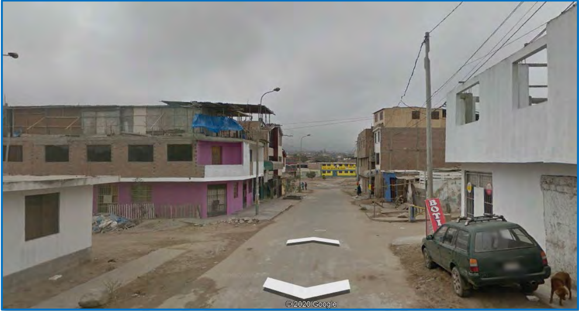
Figura 12. Viviendas de albañilería en la zona de Lomo de Corvina donde se nota que algunas pueden tener hasta 4 pisos (Fuente Google Earth)
