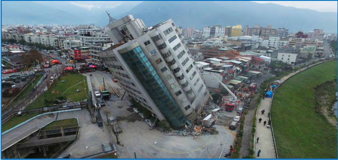
Figura 3. Edificio colapsado debido a licuefacción del suelo tras un terremoto (Fuente GeoQuantics 2020)
