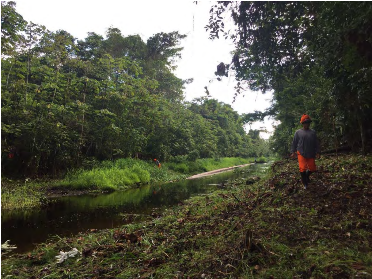
Figura 4. Trabajadores de roce y limpieza del Oleoducto Norperuano
