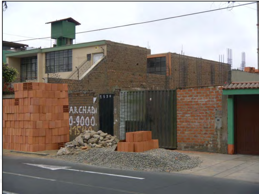
Figura 4.2: Fachada del terreno. Fuente: Elaboración propia.
