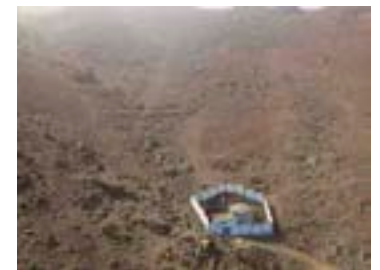
Reservorio en fondo de quebrada
