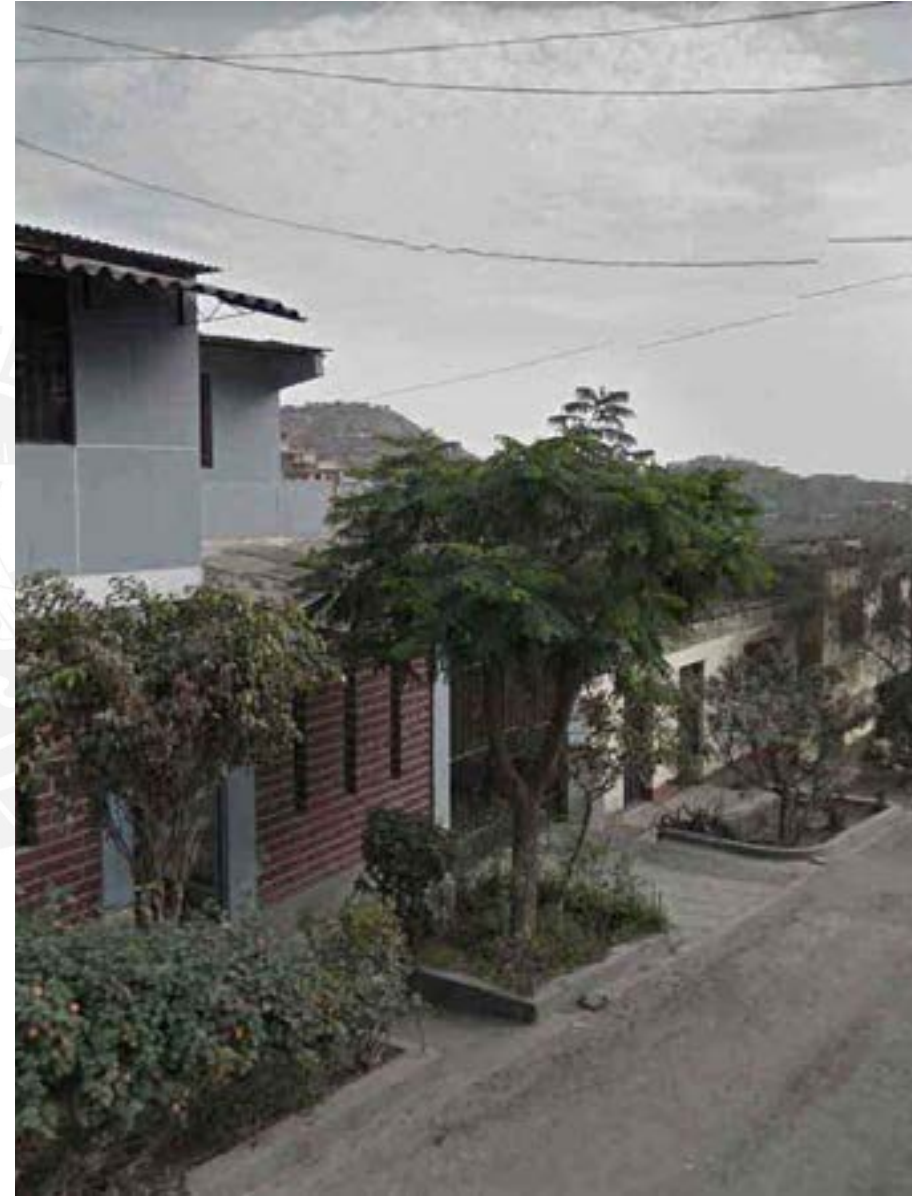
F.42 CAMINO PRINCIPAL EN QUEBRADA BAJA DE VALLE ALTO. MAYO 2013.
