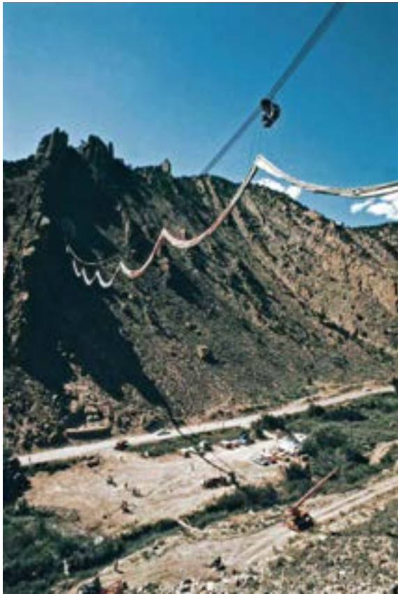
Fotografía de Shunk-Kender, del proceso de ensamblaje de la obra en Rifle, Colorado.
