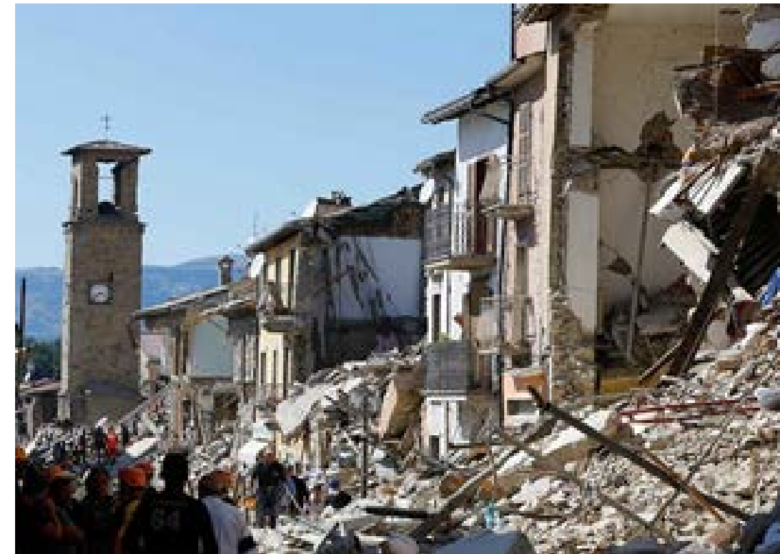
Fig. 15: Imagen de viviendas destruidas por el terremoto de 2009. Fuente: Google, 2021.
