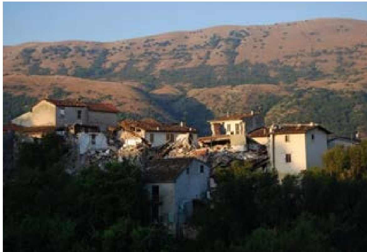
Fig. 14: Imagen de viviendas destruidas por el terremoto de 2009. Fuente: Google, 2021.
