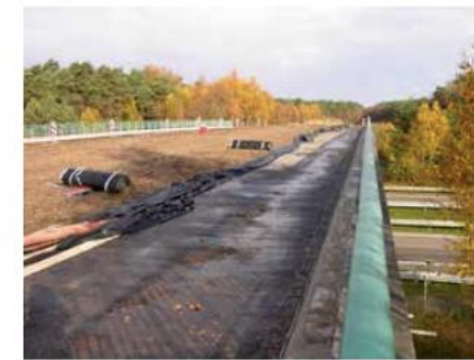
Figura 2.7. Aislamiento de la base de la estructura y drenaje de su superficie. Foto: C. Rosell.
