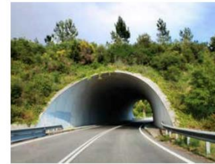
Figura 2.3. Paso situado en un tramo entre desmontes que permite depositar materiales excedentes de la excavación. Foto: M. Fernández-Bou.
