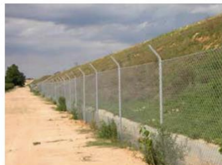
Figura 13.2. Instalación del cerramiento en la base de un terraplén. Foto: F. Navàs.
