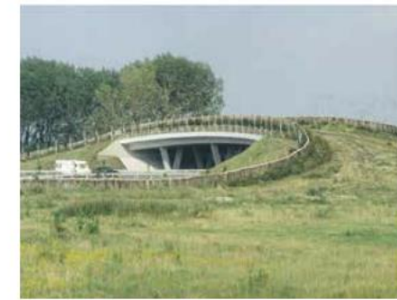
Figura 2.4. Paso situado en un terreno llano, con rampas de acceso con ligera pendiente. Foto: P. Farkas.
