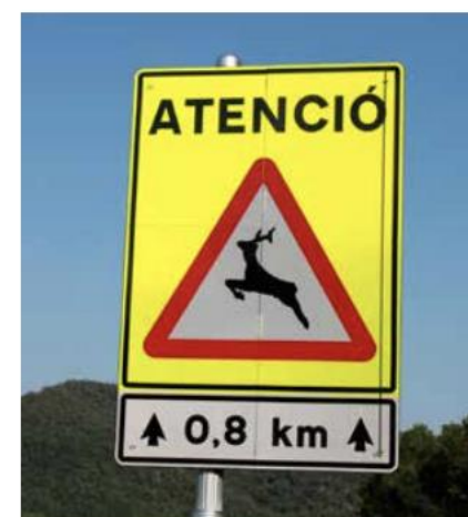
Figura 17.2. Refuerzo de señalización de advertencia operativa temporalmente, solo durante el periodo de mayor riesgo de accidentes causados por ungulados. Foto: Departament de Territori i Sostenibilitat. Generalitat de Catalunya.
