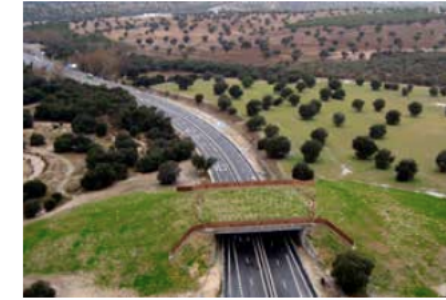
Dirección General de Carreteras, Comunidad de Madrid
