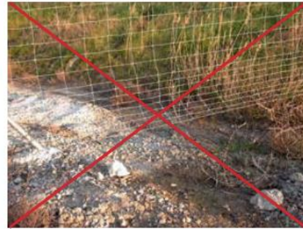
Figura 13.11. Malla sin enterrar que ha sido levantada por los animales. Foto: F. Navàs.
