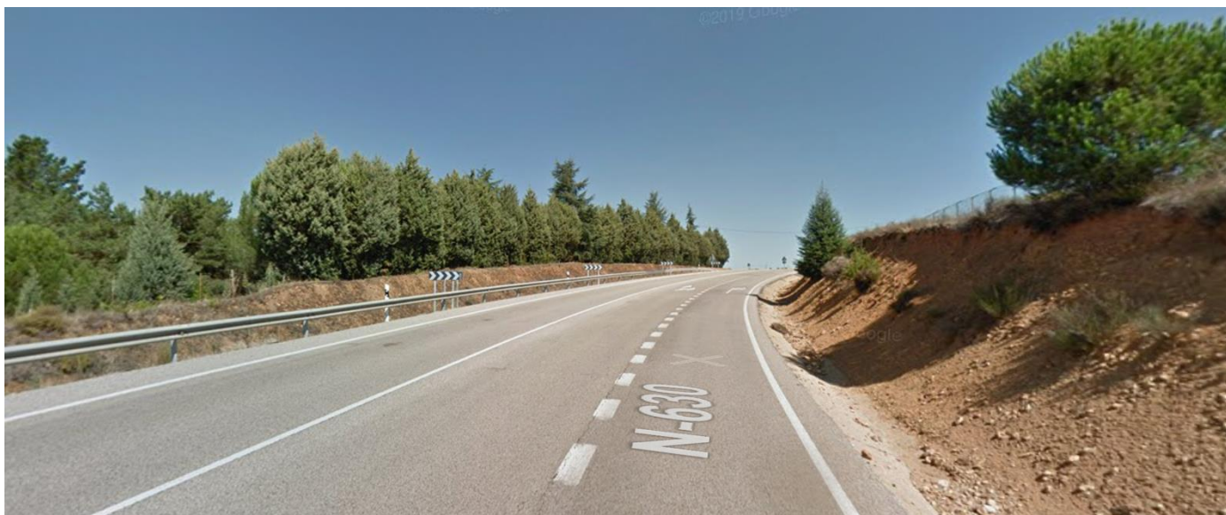
Imagen de la zona carretera N-630 en el PK-138+030.
