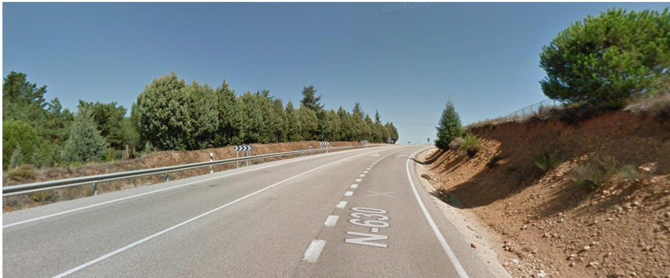
Imagen de la zona carretera N-630 en el PK-138+030.
