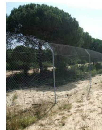
Figura 13.8. Cerramiento específico para lince ibérico. Foto: Agencia de Obra Pública. Junta de Andalucía.
