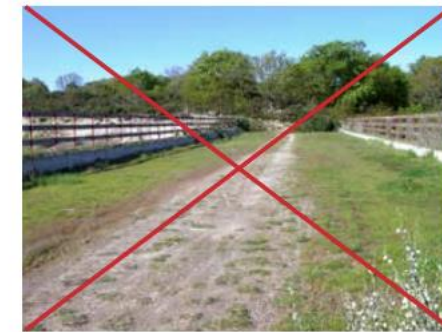
Figura 2.8. Circulación motorizada por un paso superior específico para la fauna y pantalla lateral que no es completamente opaca. Foto: C. Rosell.
