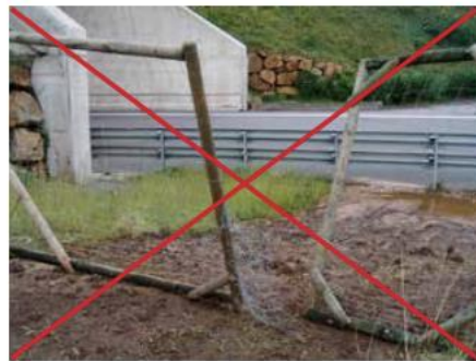
Figura 13.12. La falta de mantenimiento facilita la entrada de animales en las vías. Foto: F. Navàs.
