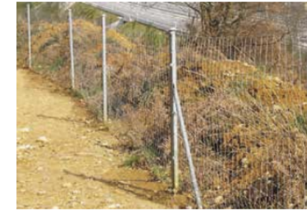
Dirección General de Carreteras, Comunidad de Madrid
