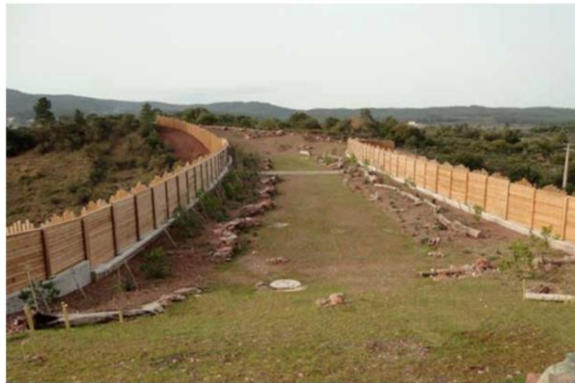
Figura 2.2. Paso superior con diversas medidas de acondicionamiento de refugios que favorecen su uso por parte de pequeños animales. Foto: Foto: S. Vanpee - Irstea.
