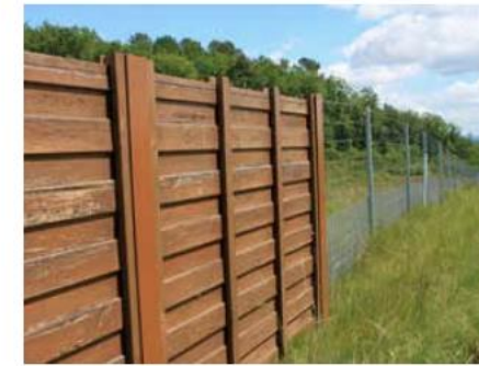
Figura 2.5. Las pantallas del paso deben mantener una perfecta continuidad con el cerramiento perimetral de la vía. Foto: C. Rosell.
