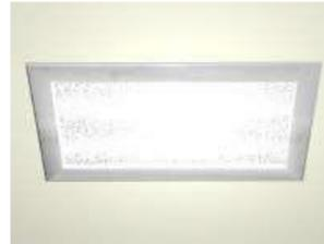
Las luminarias Downlight para falso techo, tendrán unas dimensiones de 210x210x150 mm, la iluminación se realizará mediante 2 lámparas fluorescentes compactas triples TC-TELI de 26 W, rendimiento 45%. Las luminarias serán como se muestran en la figura, y se distribuirán de la siguiente forma:
