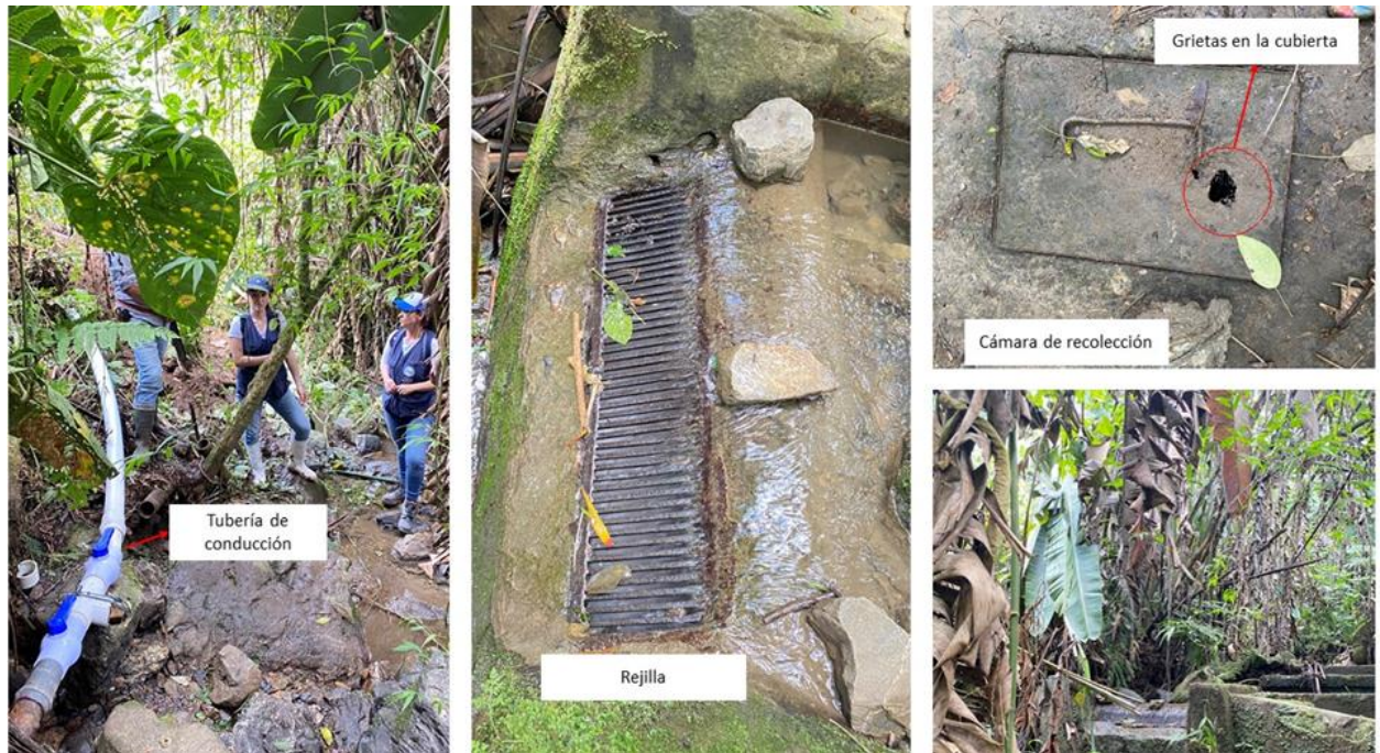
Figura 27. Captación del sistema de abastecimiento de la Vereda San Juanito, Quebrada San Miguel
