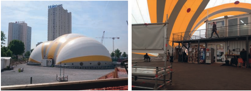
Figure 1. Structure de la « Bulle », avec porte tournante d'accès
