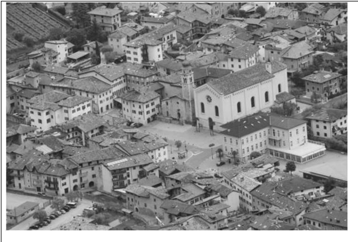
Fig. 3. Veduta aerea dell'area centrale di Dro ad intervento ultimato.
