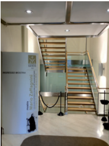
02 | Bologna, via delle Donzelle 2, sede della Fondazione del Monte, vista della scala in acciaio inox, legno e vetro, magistrale progetto tra architettura e design di Mario Zaffagnini. In primo piano il manifesto della mostra temporanea a lui dedicata.
