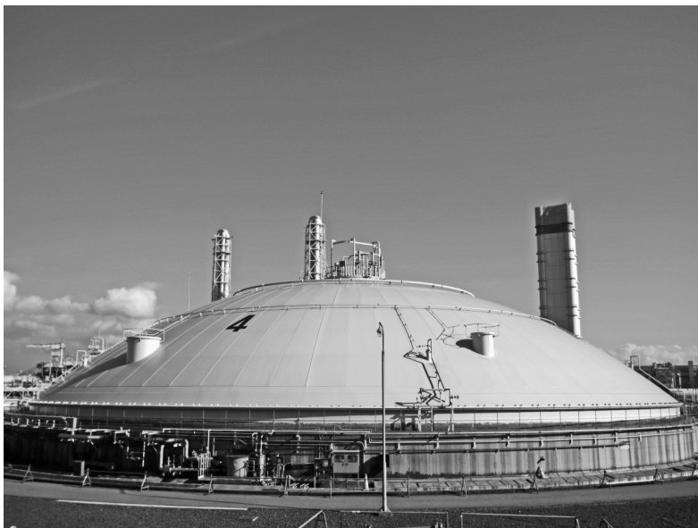
Fig. 5 - Palazzo della Tokyo Electric Power a Fukushima.
