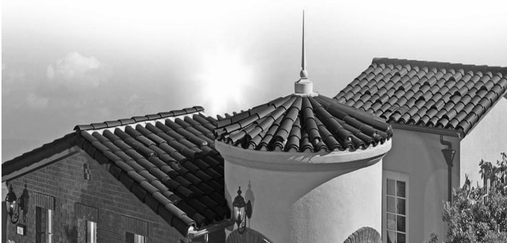
Fig. 19, 20 - Copertura con tegole a coppi alimentati da energia solare.
