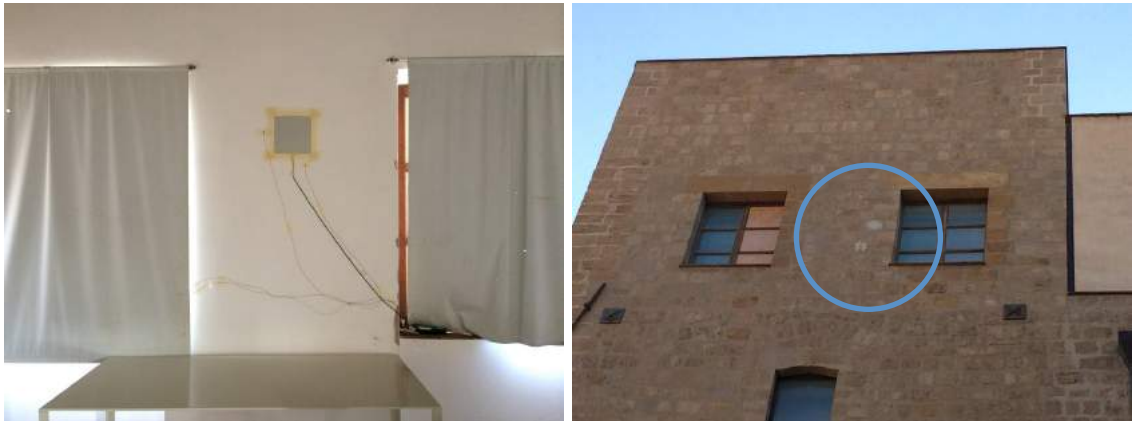
Figure 4.53, 4.54. Punto di misura 13 ( a sinistra ) e posizione dei sensori esterni di temperatura ( a destra ).
