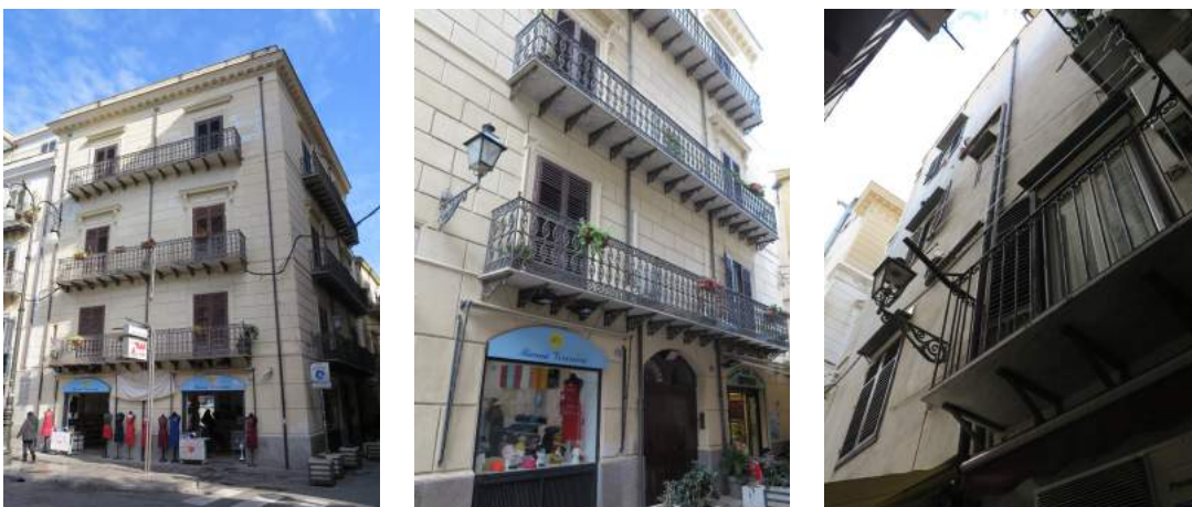
Figure 7.8, 7.9, 7.10. Edificio in via Bara all'Olivella.
