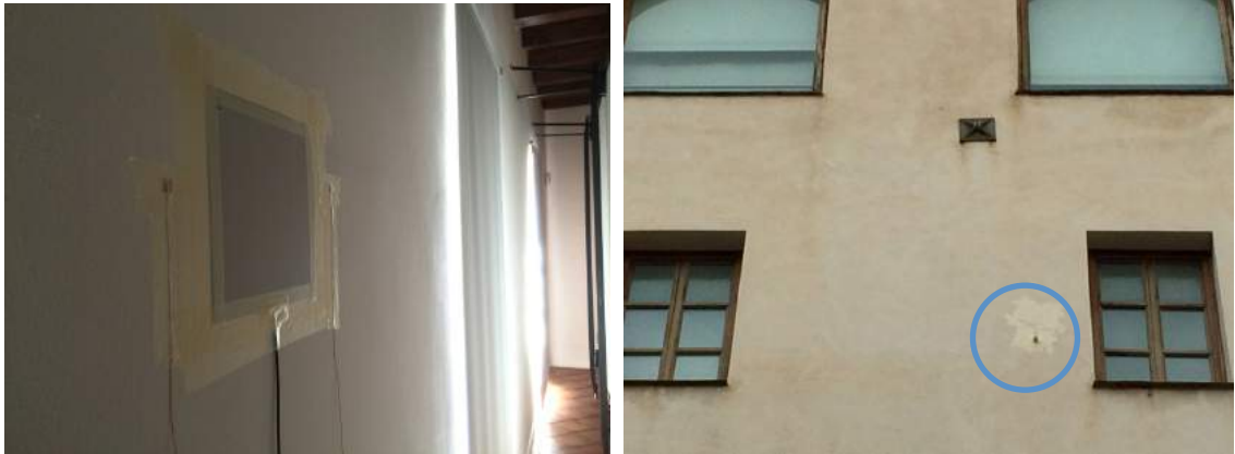
Figure 4.51, 4.52. Punto di misura 12 ( a sinistra ) e posizione dei sensori esterni di temperatura ( a destra ).
