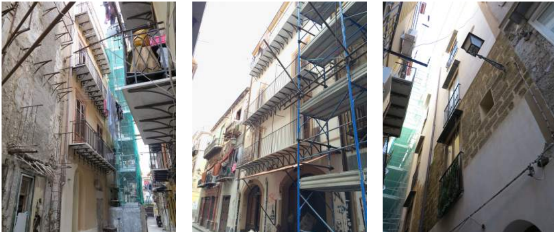
Figure 7.5, 7.6, 7.7. Edificio in vicolo della Madonna (a sinistra). Edificio su via Argenteria (al centro e a destra).
