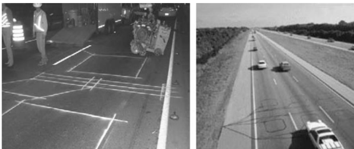
Figura 5 - A sinistra posa in opera di spire induttive in configurazione double-loop, a destra il risultato finale
