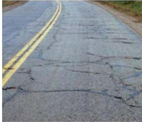
Fig. 3.9 - Gravi fessurazioni su pavimentazioni stradali.
