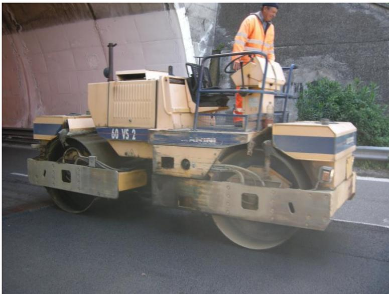
Fig. 5.2 – Rifacimento superficiale: Compattazione.
