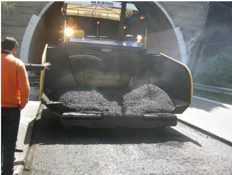
Fig.5.1 – Rifacimento superficiale: Stesa del conglomerato bituminoso.
