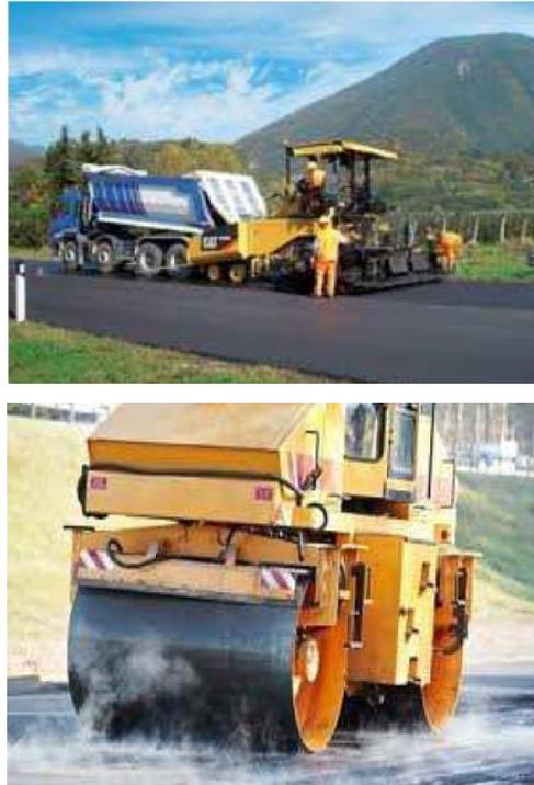
Fig. 4.4 A sinistra: Fase di stesa; a destra: fase di compattazione [2].
