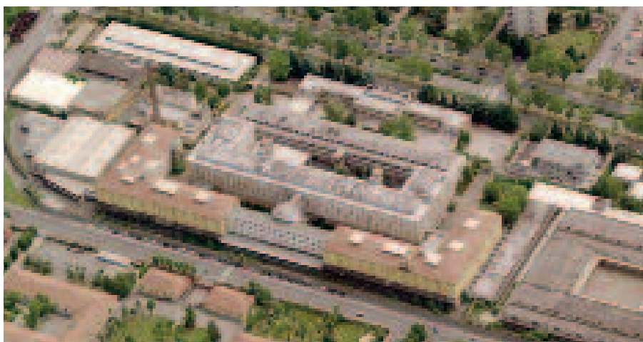
Fig. 97. Foto aerea della rigenerazione in atto.
