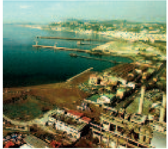
Fig. 61. Foto area dell'area industriale, anni 80.
