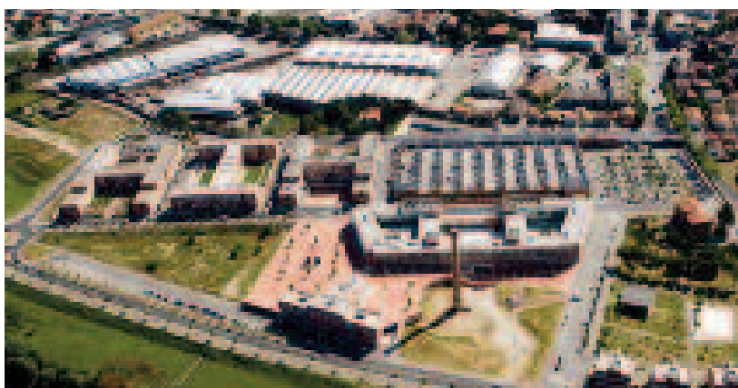
Fig. 82. Foto aerea dell'intervento di rigenerazione dell'area industriale.
