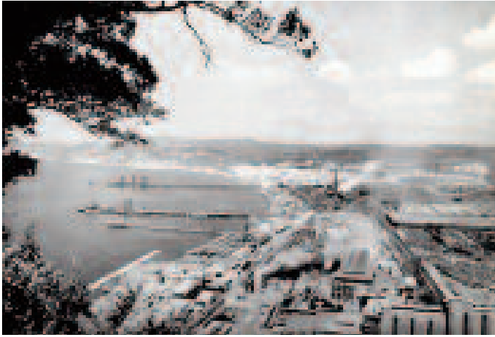
Fig. 61. Foto area dell'area industriale, anni 60.
