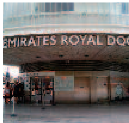
Fig. 48. Ingresso Emirates Royal Docks.
