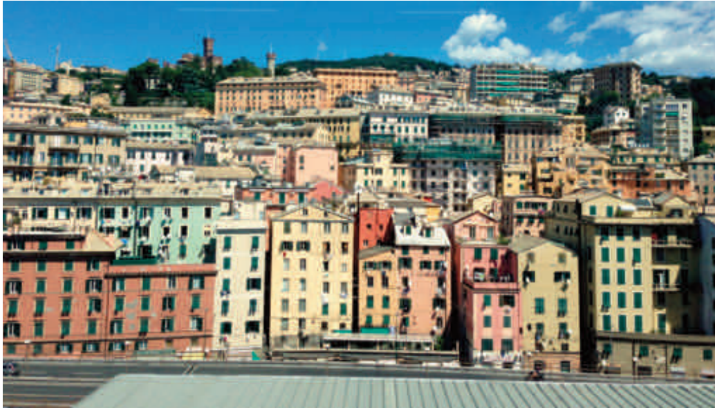
Fig. 92, - La palazzata del fronte a mare di Genova, 2013.
