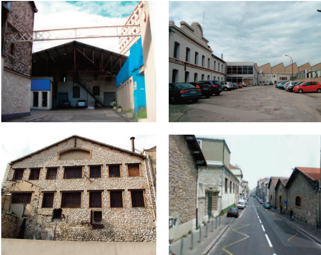
Figg. 61, 62, 63, 64 - Edifici industriali all'interno del perimetro di Euromed II , 2014.
