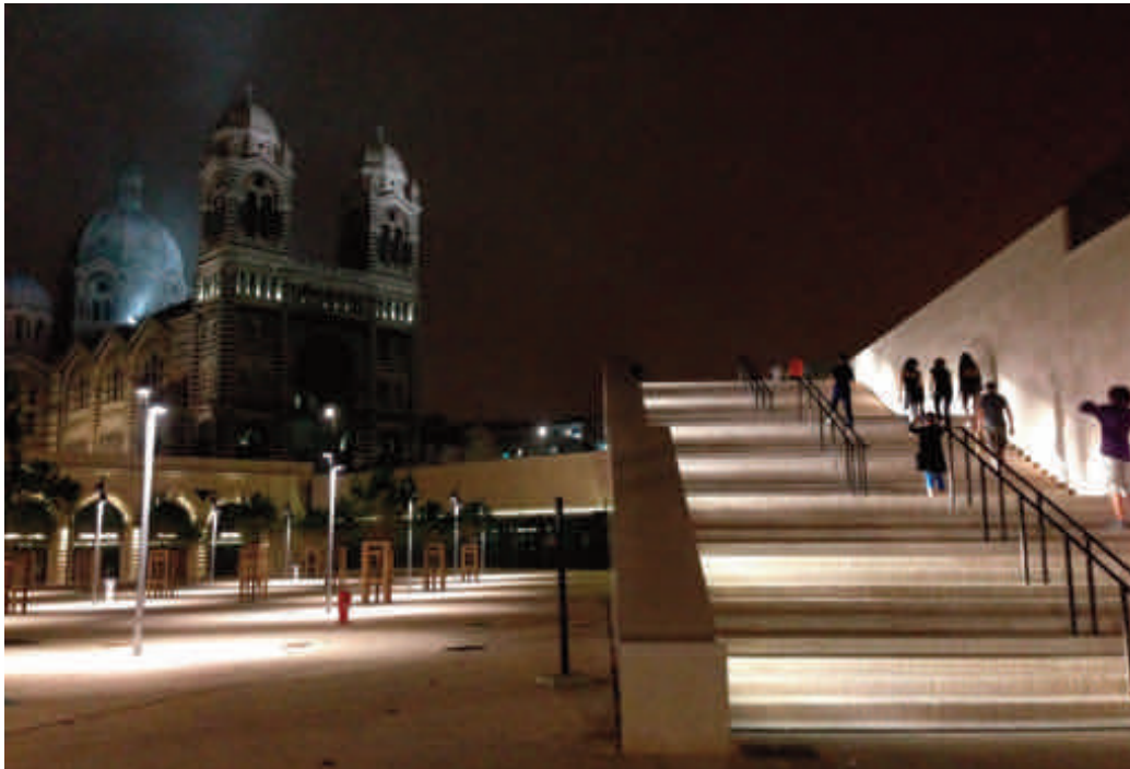
Fig. 25 - La risalita della Cathédrale de la Vieille Major (2014), arch. B. Fortier, 2014.
