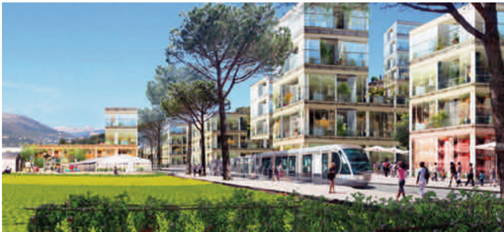
Fig. 103 - Il progetto per l' Éco-Vallée Plaine du Var , 2011, © Éco-Vallée Plaine du Var .
