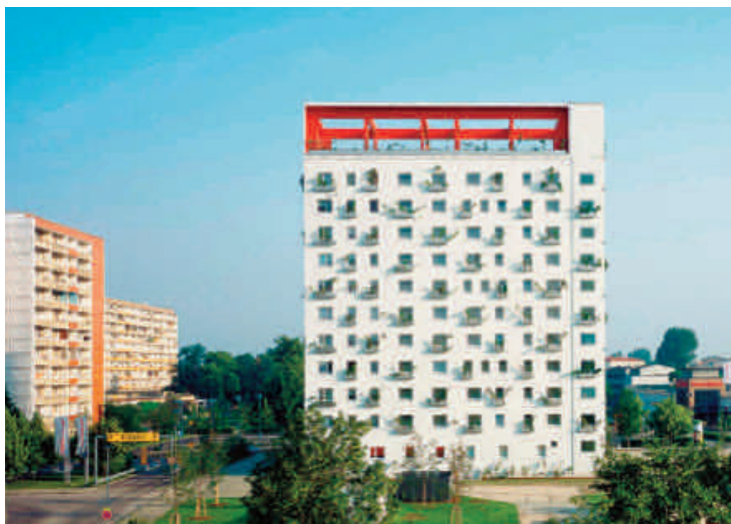
Fig. 29 - La riabilitazione di un edificio a Hoyerswerda in Germania dell'arch M. Petzet, 2007, © Muck Petzet.
