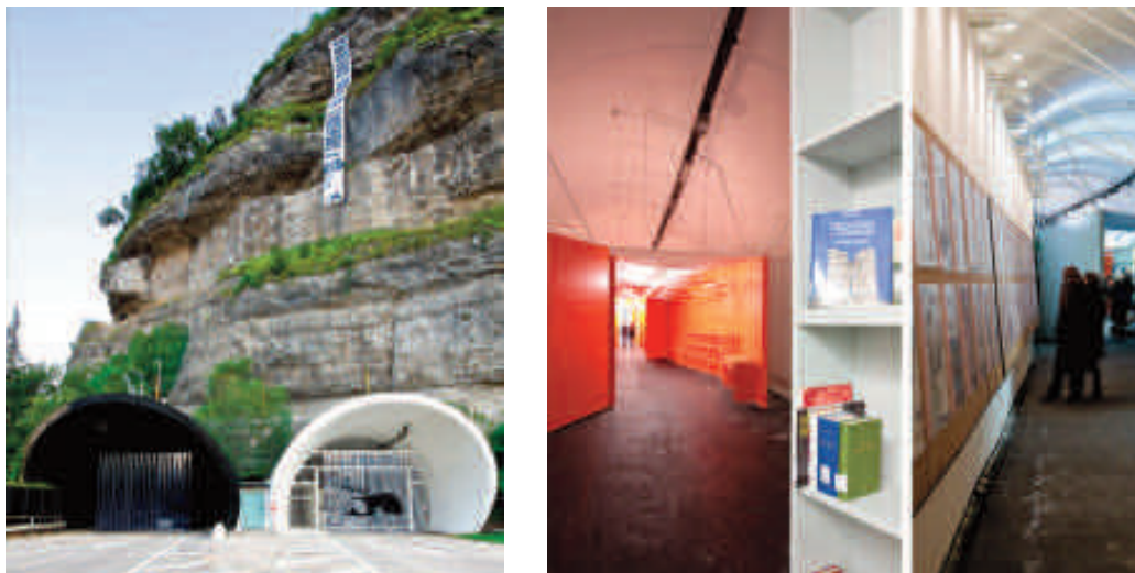
Figg. 42, 43 - Le due gallerie dismesse Piedicastello trasformate nel Museo Storico del Trentino, a Trento, dell'arch. E. Terragni, 2007-2009, © Terragni.
