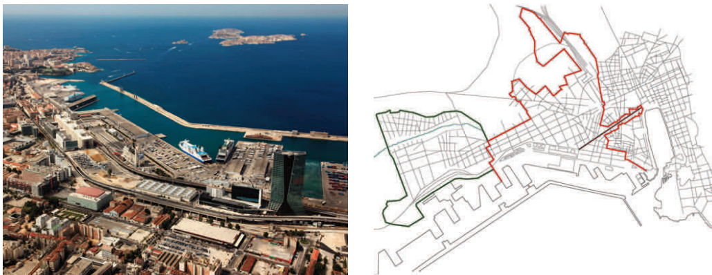
Figg. 13, 14 - L'area portuale oggetto d'intervento nella prima fase di Euromediterranée , 2011, © GPMM. Ridisegno del perimetro del progetto Euroméditerranée , 2013.
