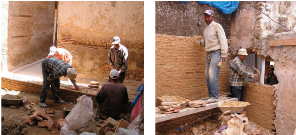
Figg. 96, 97 - Un cantiere diretto dall'ASM nella Medina di Tunisi, 2008.
