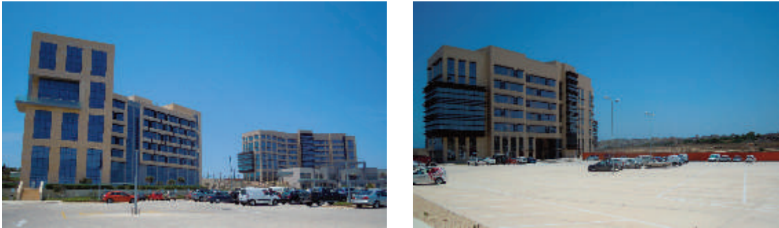
Fig. 47 – Le aree adibite a parcheggio della Smart City Malta . Sullo sfondo, a sinistra, gli edifici SCM 01-02 e a destra, l' SCM 02 .
