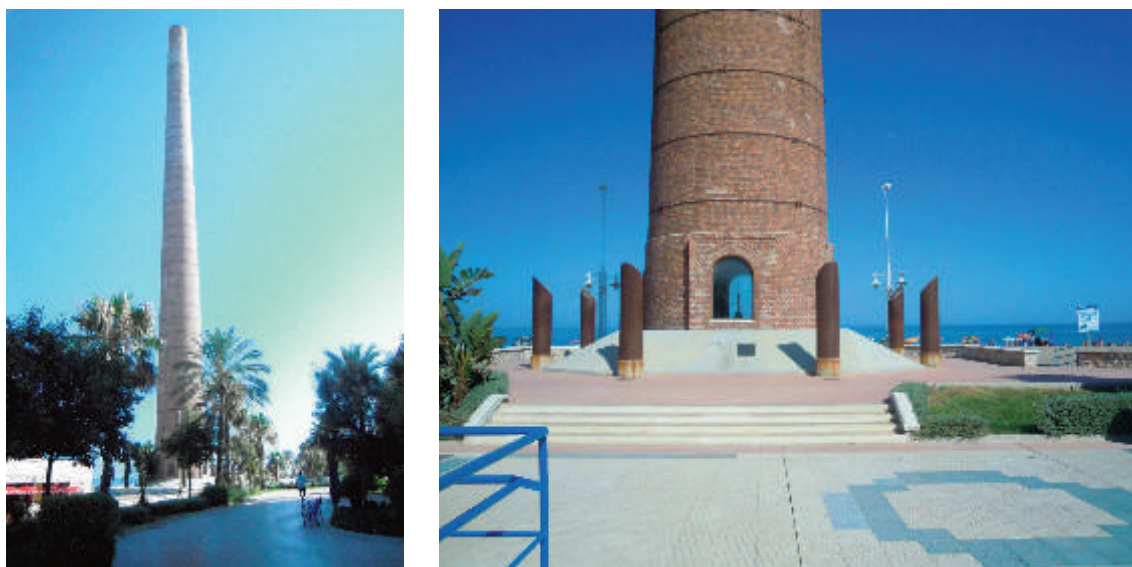
Fig. 39 – La ciminiera in mattoni resto del passato industriale del quartiere.
