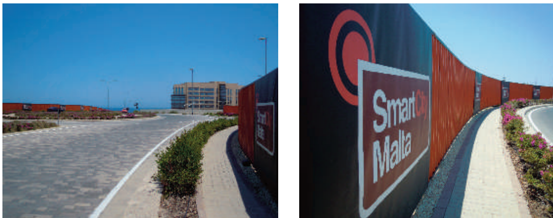
Fig. 38 – L'ingresso al sito Smart City Malta .
