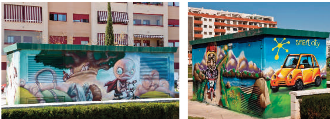
Fig. 58 - Realizzazione dei graffiti nelle cabine della smart grid di Malaga.
