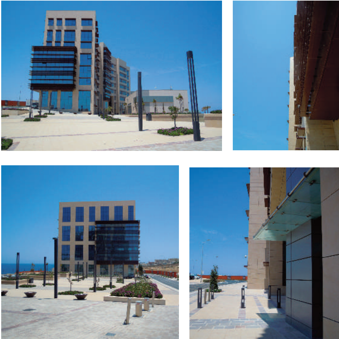
Fig. 60 – Particolari della facciata dell'edificio SCM01 .
