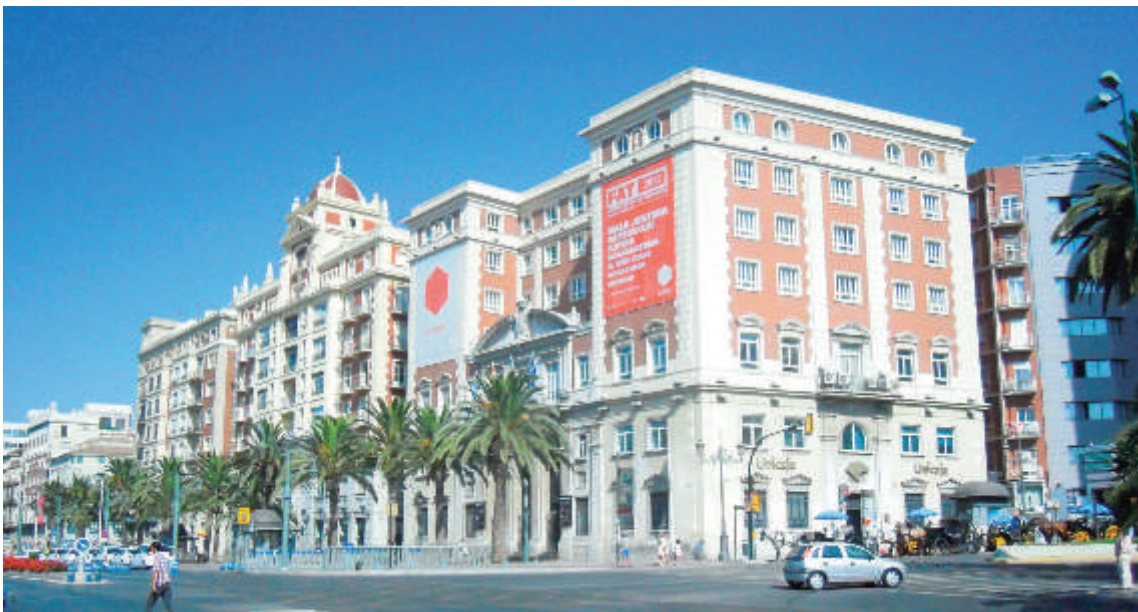
Fig. 50 – L'edificio de La Termica di Malaga, restaurato e oggi edificio intelligente , centro culturale e ricreativo.
