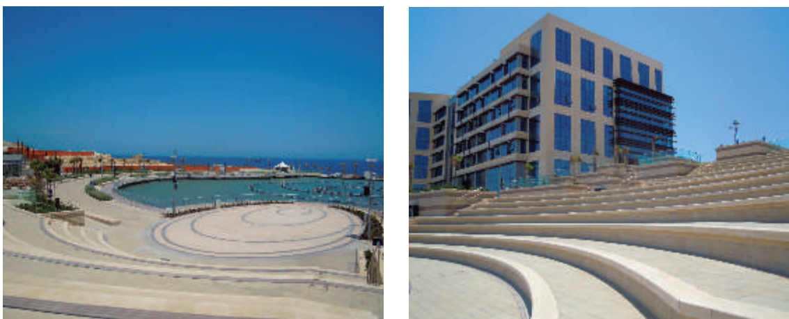
Fig. 58 – L'auditorium all'aperto della Smart City Malta.
