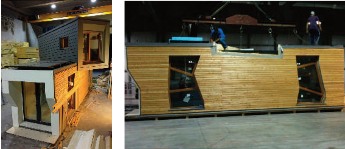
Figg. 9-10 – Il modello passivehaus “ biosPHera ”, progettato secondo i principi smart , in fase di costruzione, © 2005-2014 Edilportale.com Spa.
