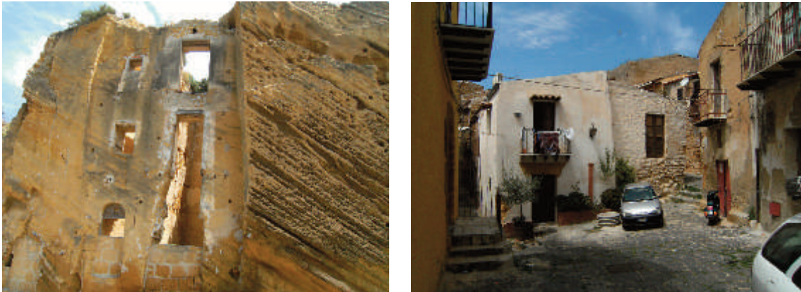
Fig. 21 - A sinistra, ruderi di case scavate nella roccia, nel Rabato ; a destra, edifici tipici, a uno o a due livelli, in uno dei cortili del quartiere.
