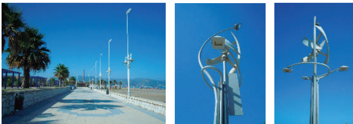
Fig. 45 - Microsistemi di energia eolica lungo il Paseo Marítimo della Playa de la Misericordia .
