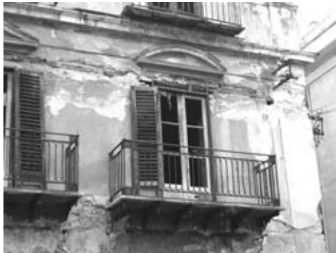
Fig. 7.17, 18 – La biacca, molto resistente all'acqua, costituiva il principale componente delle pitture per infissi esterni. Dal degrado di questi ultimi derivano i maggiori rischi per la salute (da Cantalupi).
