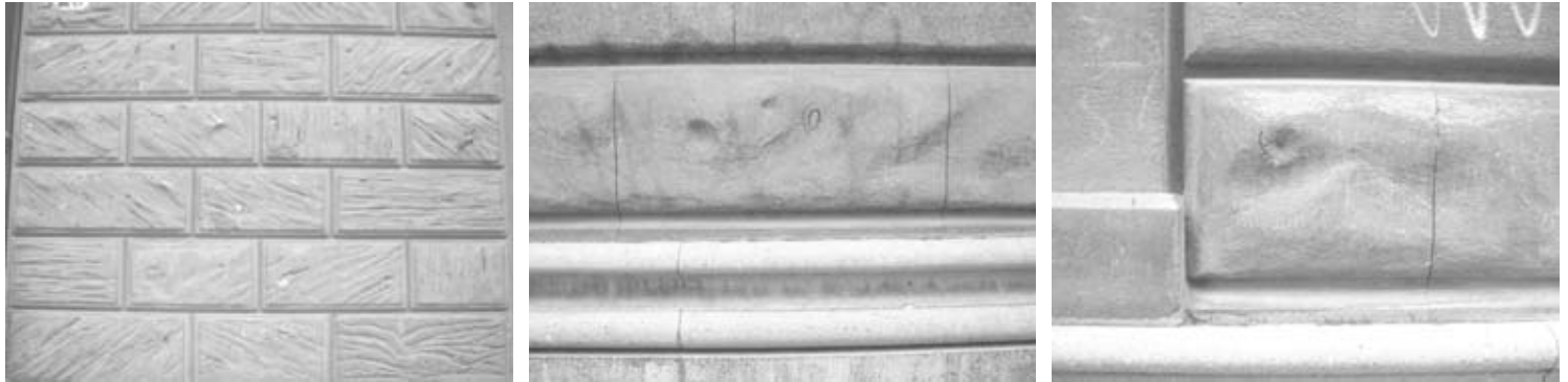
Fig. 8.30, 31, 32 – Trattamento superficiale dell'intonaco ad imitazione della calcarenite conciliare in alcuni edifici palermitani.
