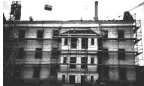
Fig. 2.21, 22 – (Sopra e a destra) Demolizione selettiva di edifici della seconda metà del XIX secolo nel quartiere operaio francese di Mulhouse L'intervento è stato eseguito sotto la direzione dei tecnici del CSTB al fine di valutare e confrontare costi e benefici relativi ad interventi di demolizione tradizionali e di demolizione selettiva.
