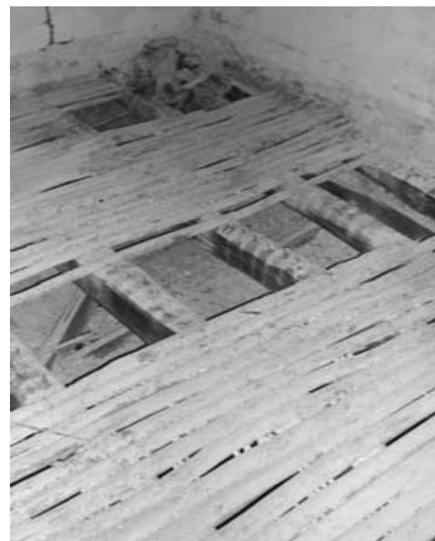
Fig. 9.8, 9 – Solaio in legno di area tedesca con tavolato posto tra le travi. (sotto) solaio con serrazzato.
