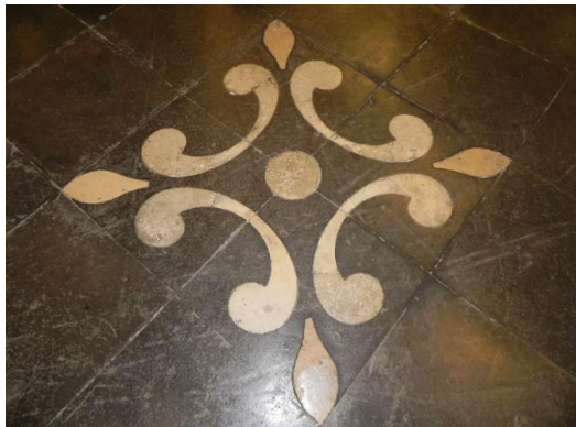
Figura 4 - Particolare del pavimento.
