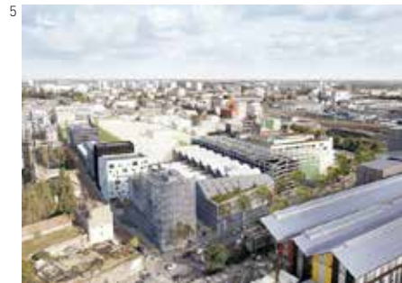
5 Nantes, Quartier de la Création.
