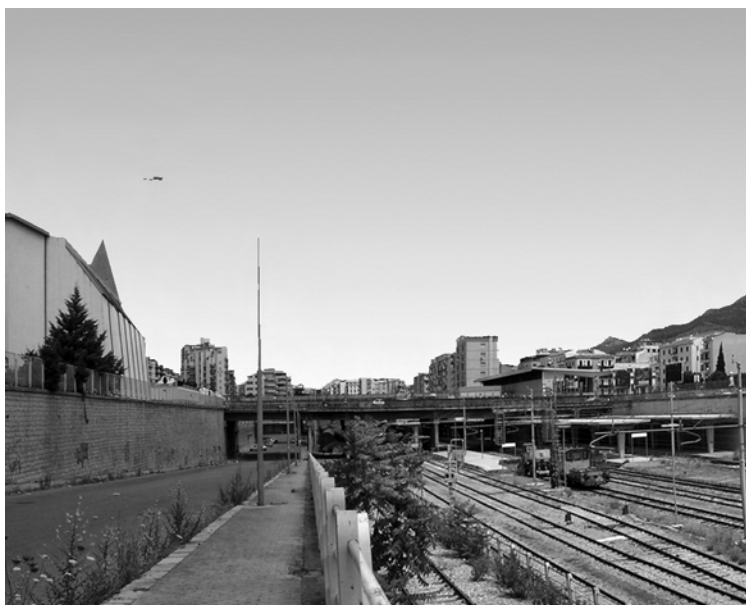
8 - 9 La linea ferroviaria in trincea in corrispondenza di via Notarbartolo
