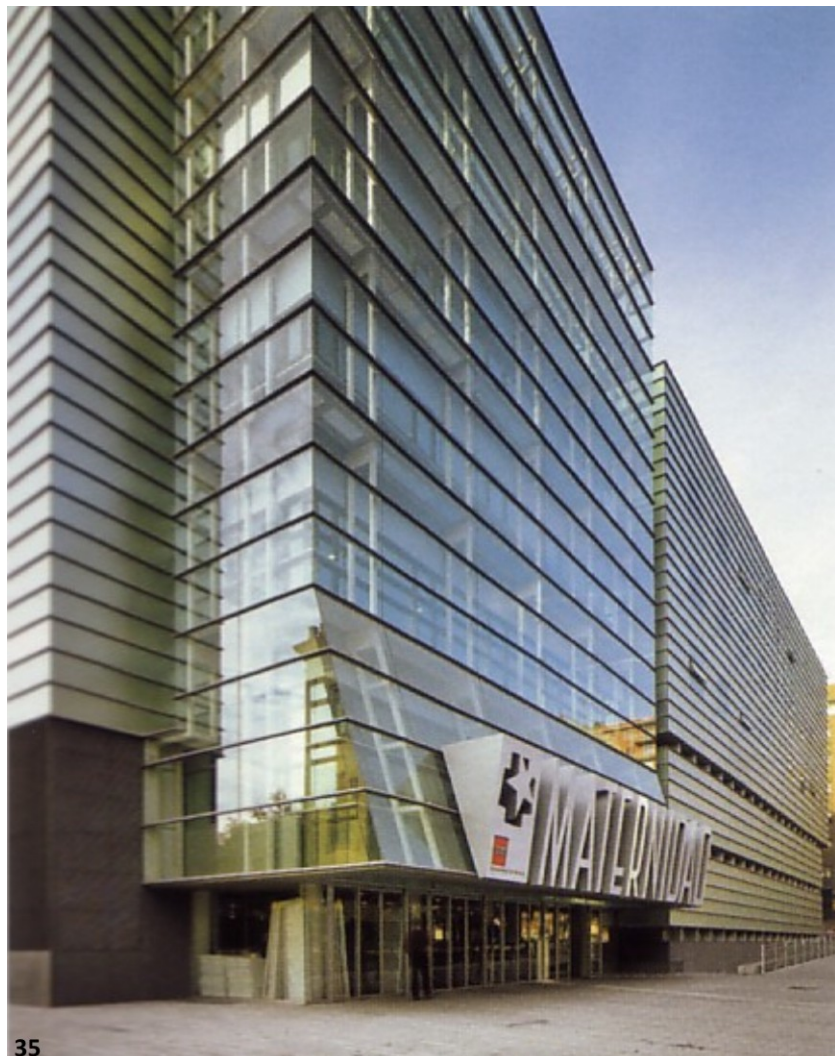
35. Ospedale Pediatrico Gregorio Marañón, Madrid, 1996-2003: l'ingresso alla Maternità.
