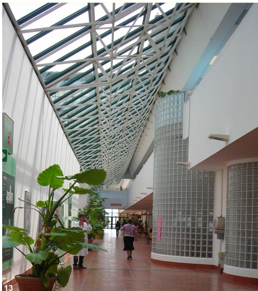
13. La galleria con i ballatoi aggettanti e la copertura vetrata.
